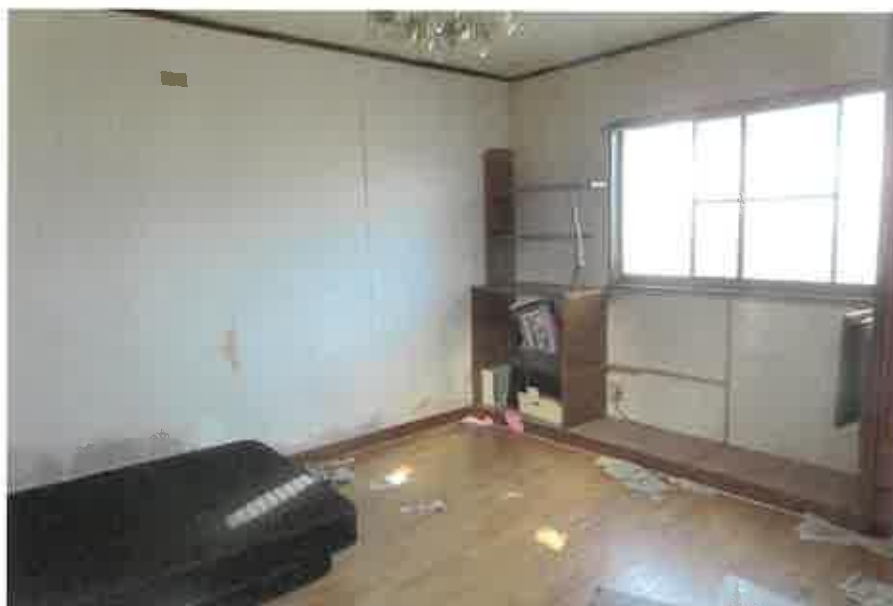
物件2主である建物:2階洋室の状況
