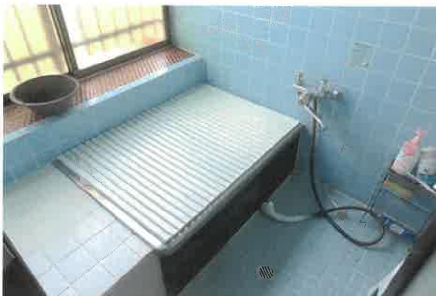
物件2主である建物:1階浴室の状況
