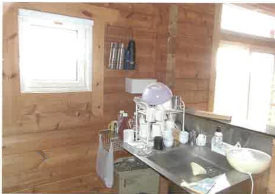
物件3主である建物:キッチンの状況
