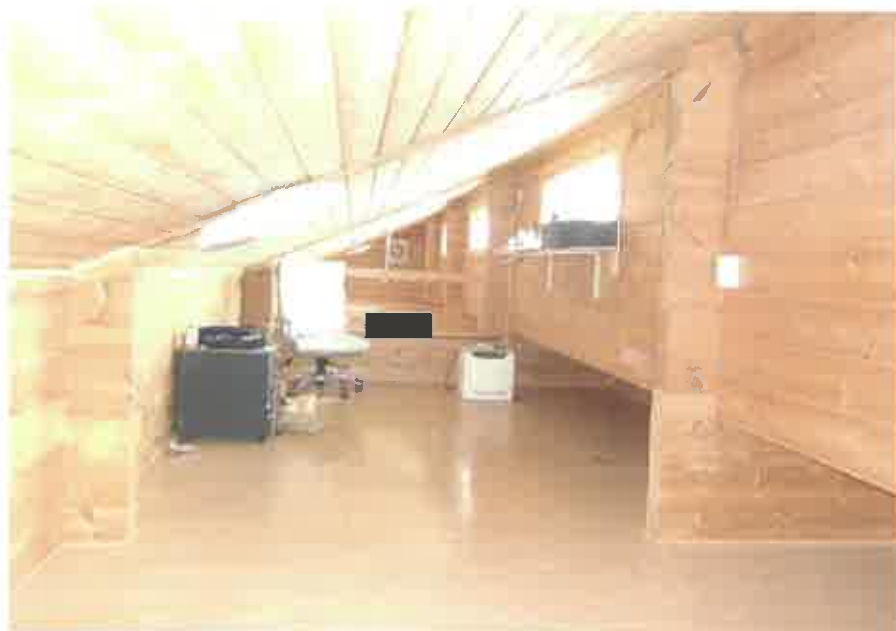
物件3主である建物:小屋裏収納の状況
