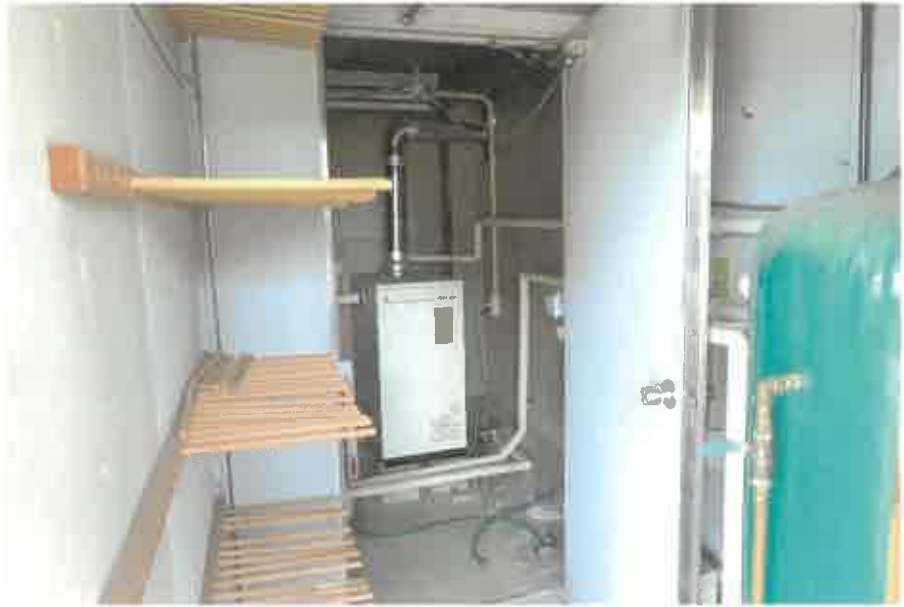
物件2居宅部分:1階ボイラー室の状況
