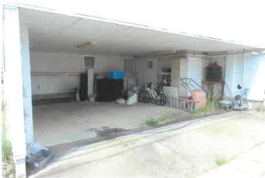
物件2居宅部分:1階車庫の状況
