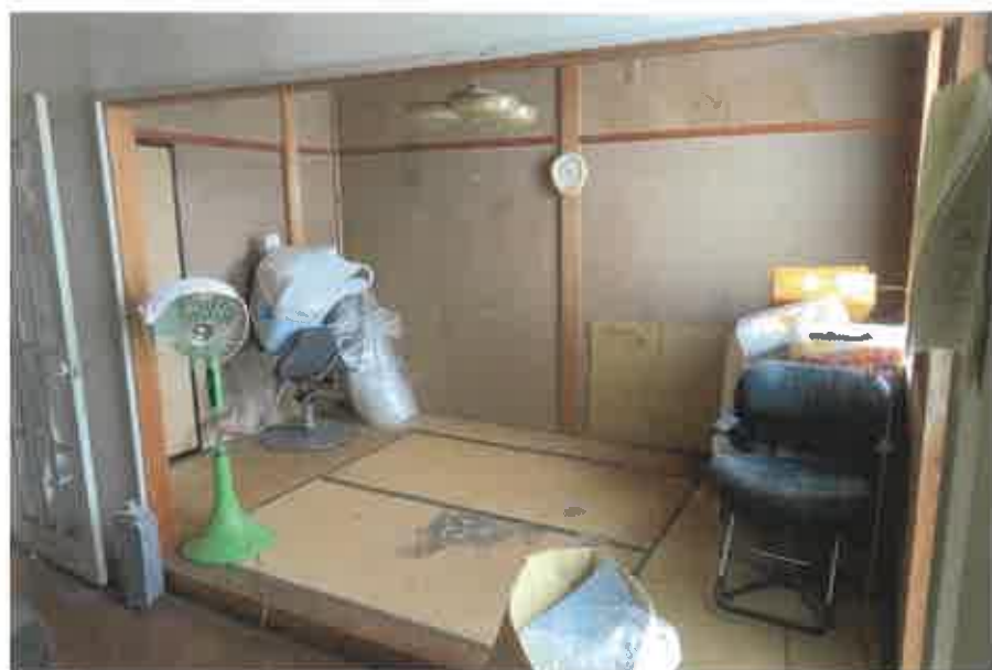
物件2居宅部分:1階和室2の状況
