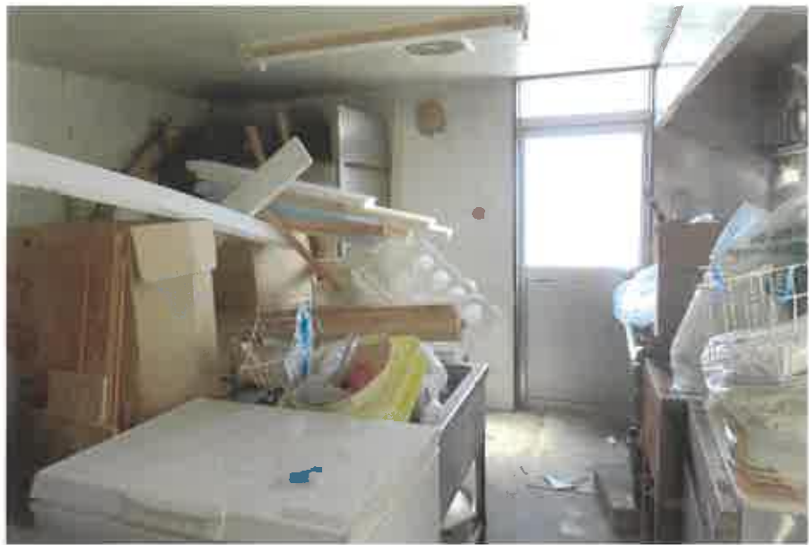
物件3:1階厨房の状況
