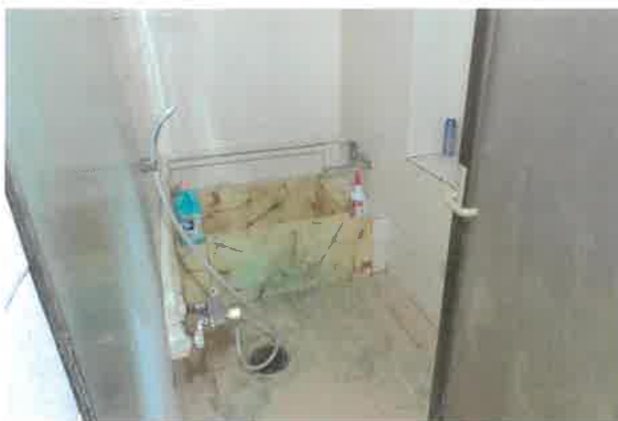
物件2居宅部分:1階浴室の状況
