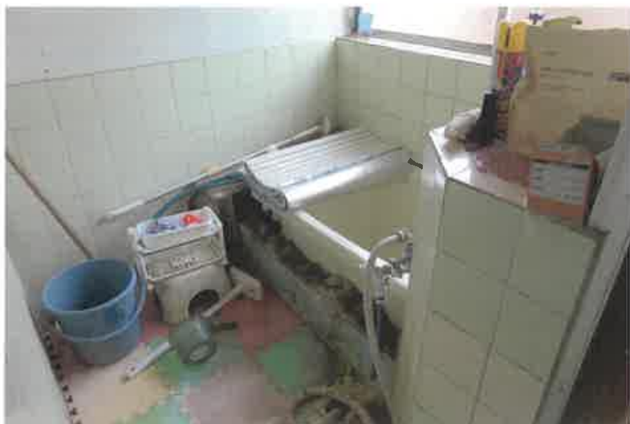
物件2:浴室の状況
