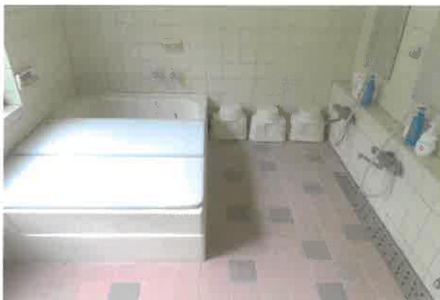
物件2:1階浴室－1の状況
