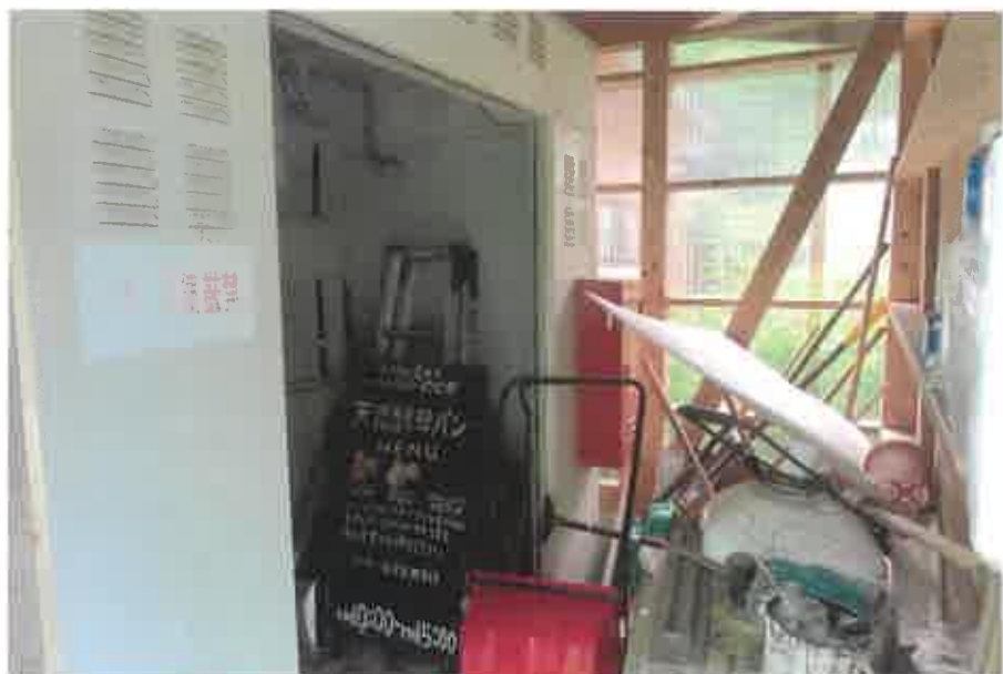
物件2未登記増築部分:プロパンガス置場の状況
