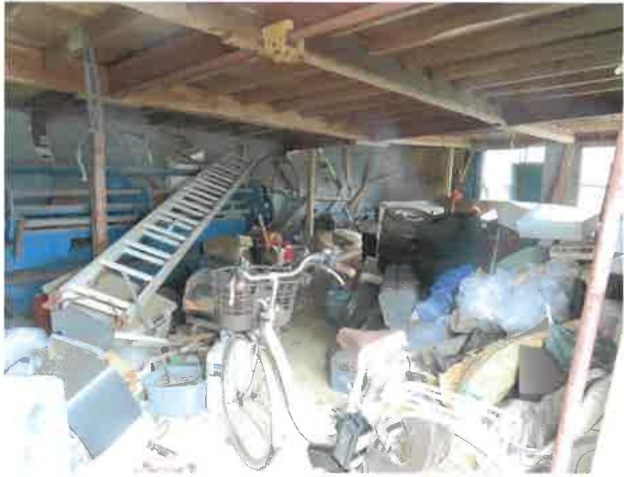
物件4未登記附属建物:1階物置の状況
