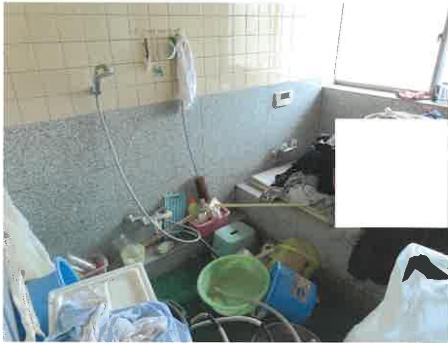
物件4主である建物:浴室の状況
