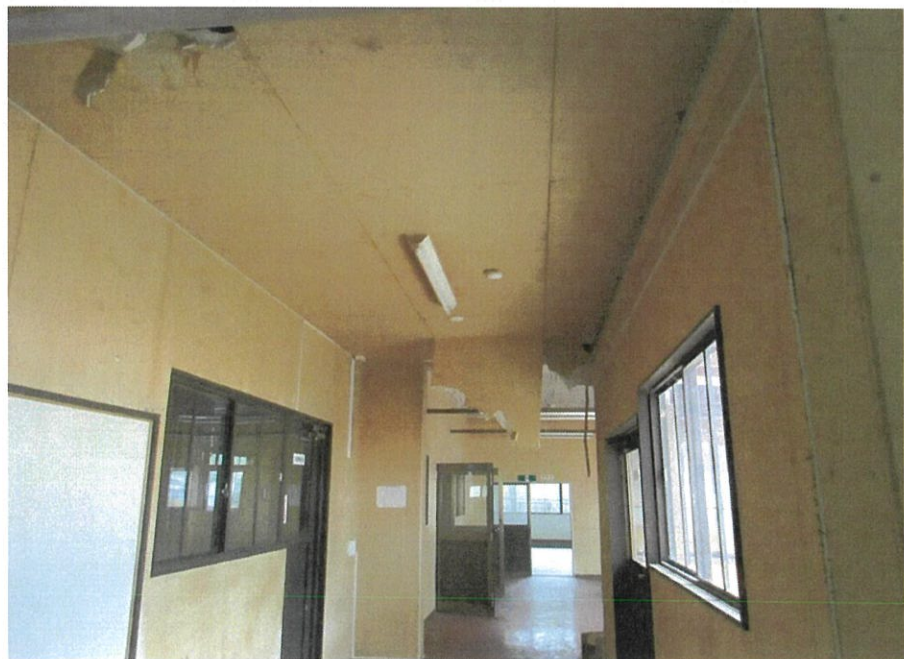
物件10と物件11間の渡り廊下の状況
