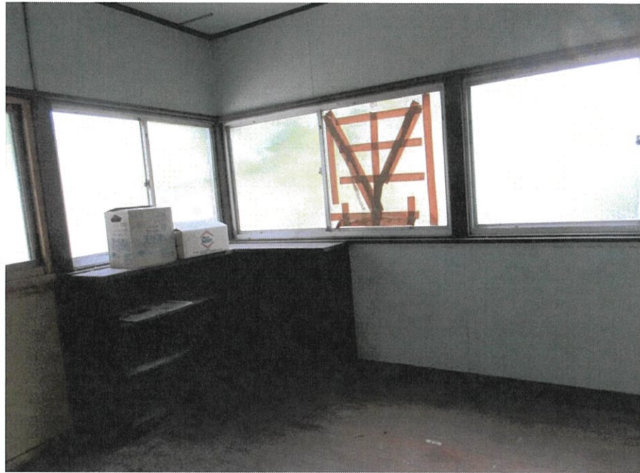
物件11:工具室の状況
