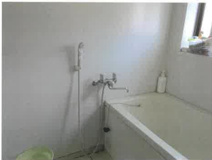
物件2:2階浴室の状況
