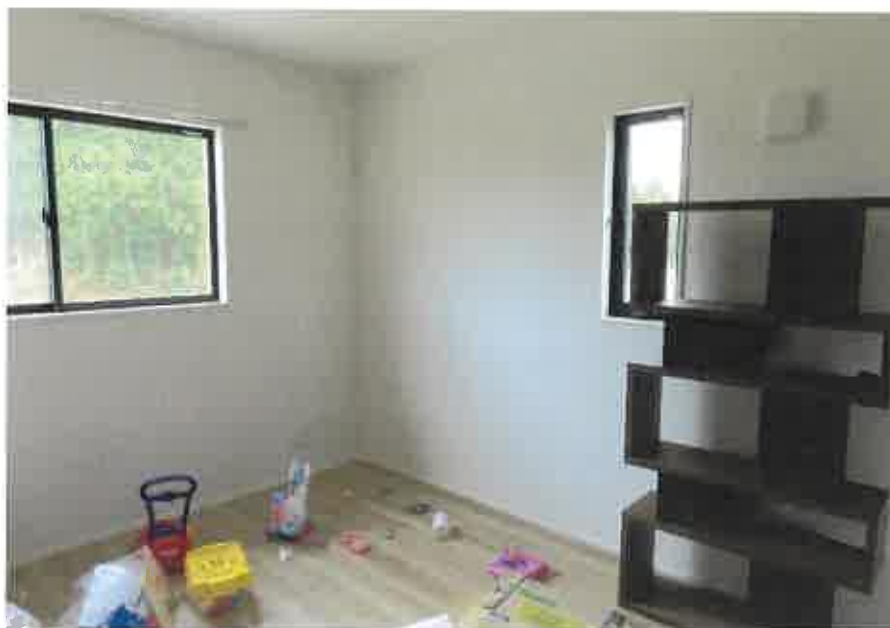
物件2:2階南西側洋室の状況
