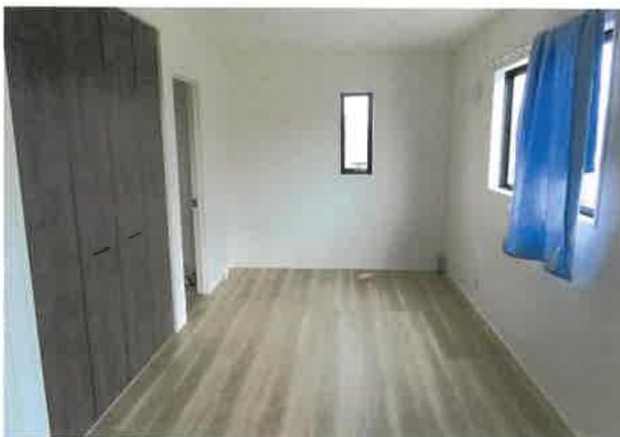
物件2:2階北東側洋室の状況
