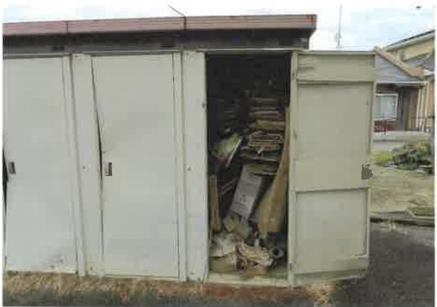
物件3附属建物符号2:内部の状況
