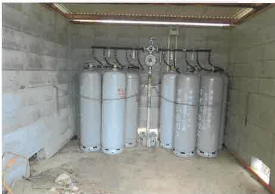
物件3附属建物符号3:内部の状況
