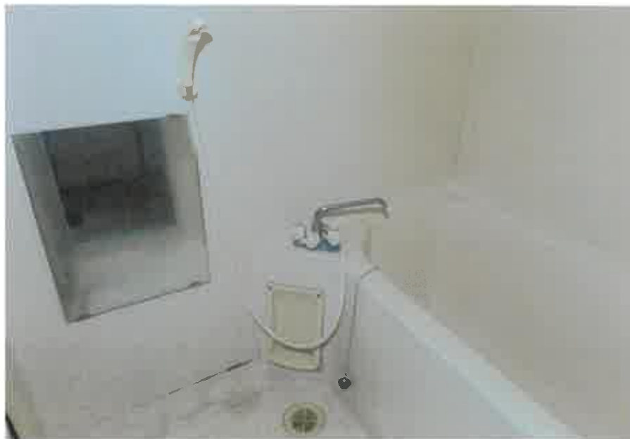
物件3主である建物:114号室浴室の状況
