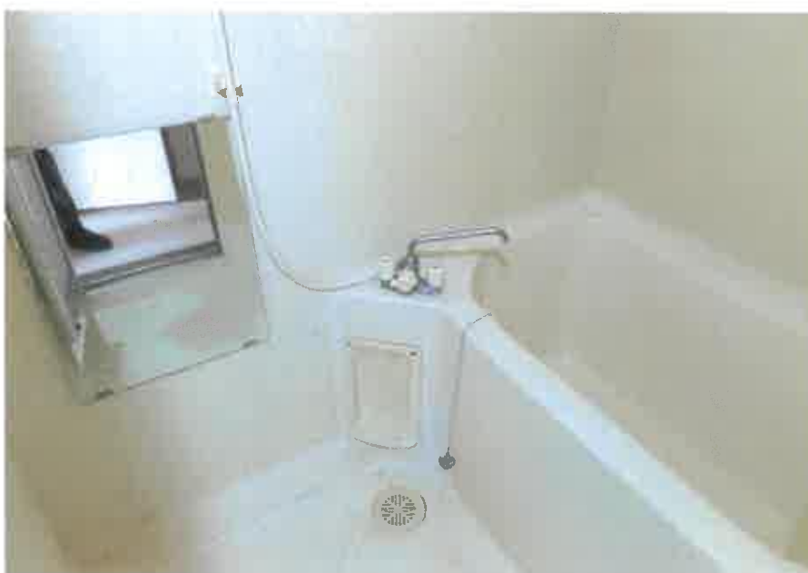
物件3主である建物:111号室浴室の状況
