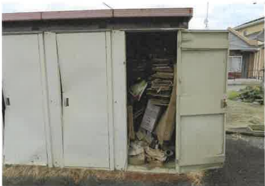
物件3附属建物符号2:内部の状況
