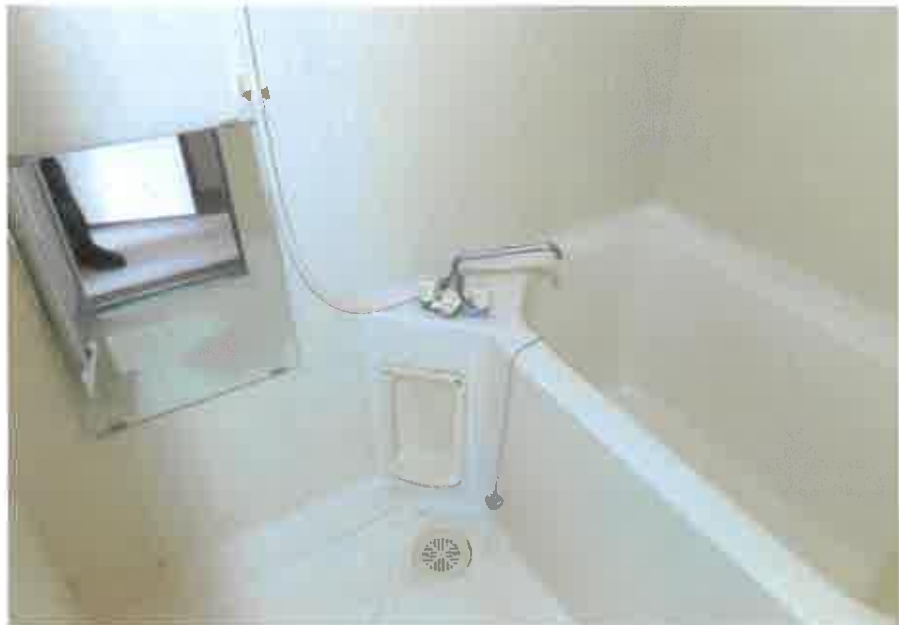
物件3主である建物:111号室浴室の状況
