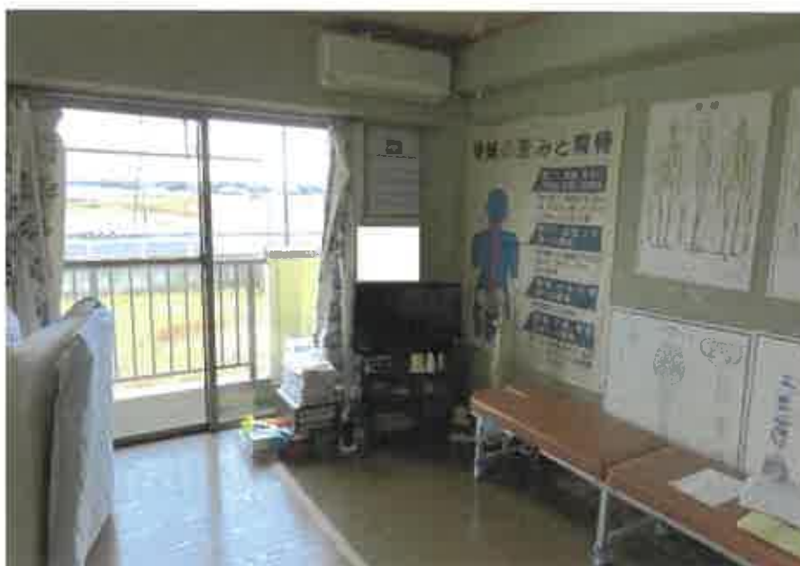
物件3主である建物:215号室南側和室の状況
