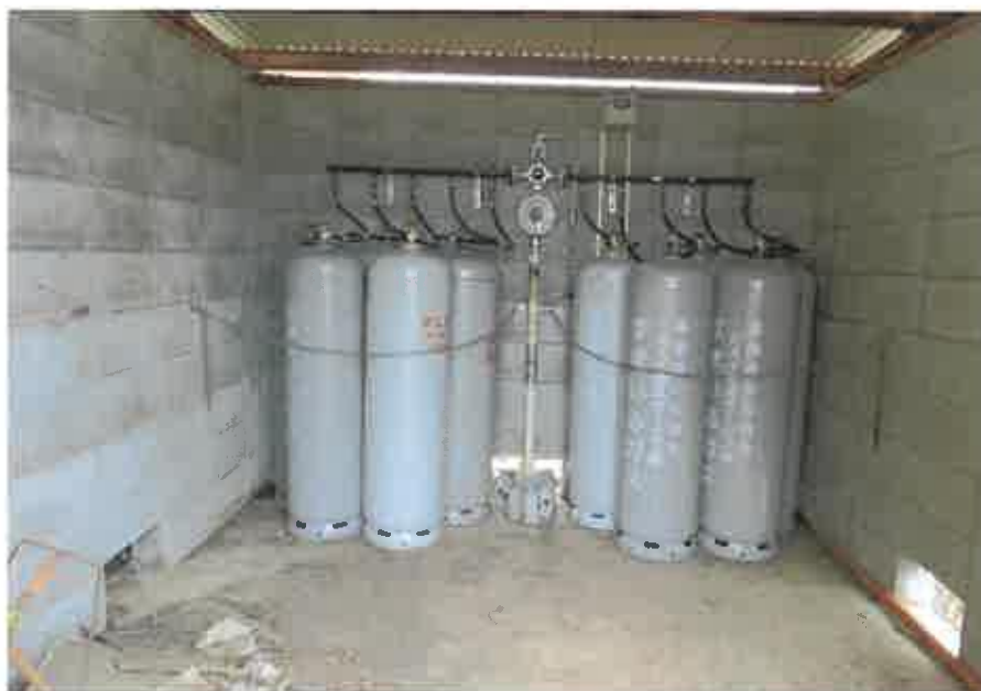
物件3附属建物符号3:内部の状況
