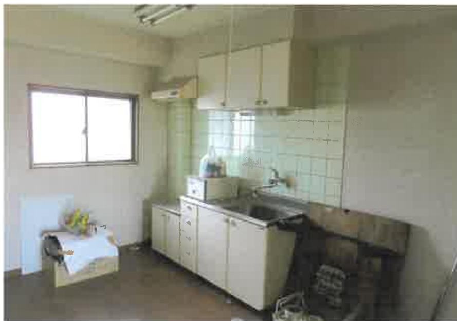
物件3主である建物:114号室ダイニングキッチン状況
