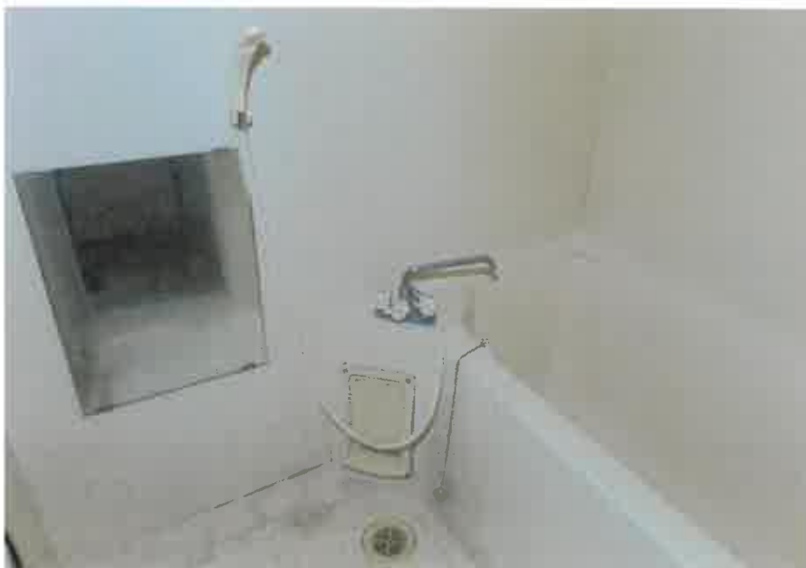
物件3主である建物:114号室浴室の状況
