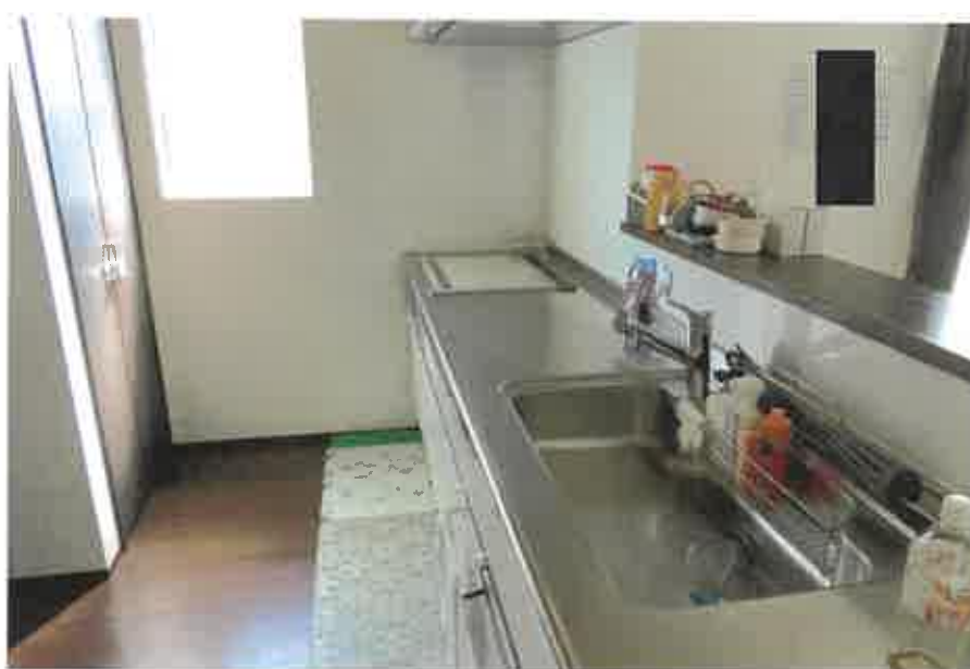
物件3:1階キッチンの状況
