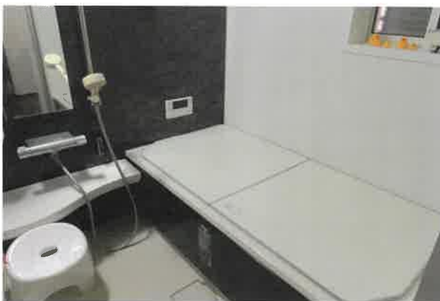
物件3:1階浴室の状況
