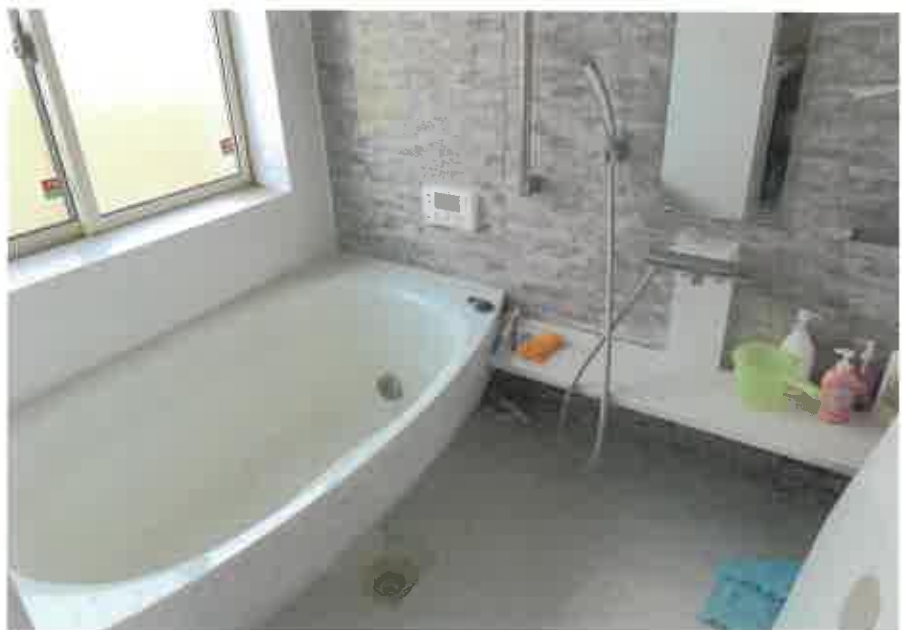
物件2:1階浴室の状況
