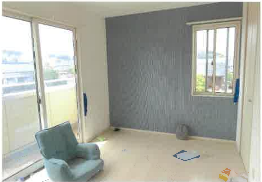
物件2:2階南西側洋室の状況
