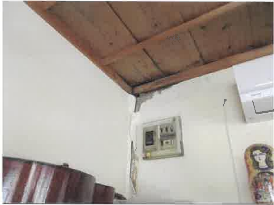
物件8:附属建物符号1の内部の雨漏り跡
