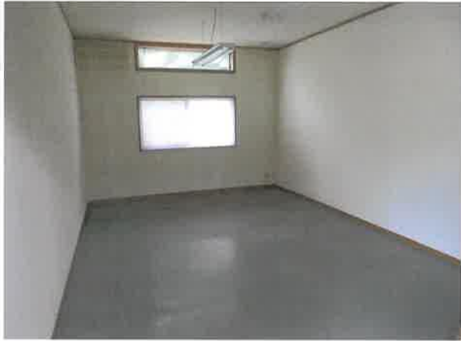
物件8: 応接室の状況
