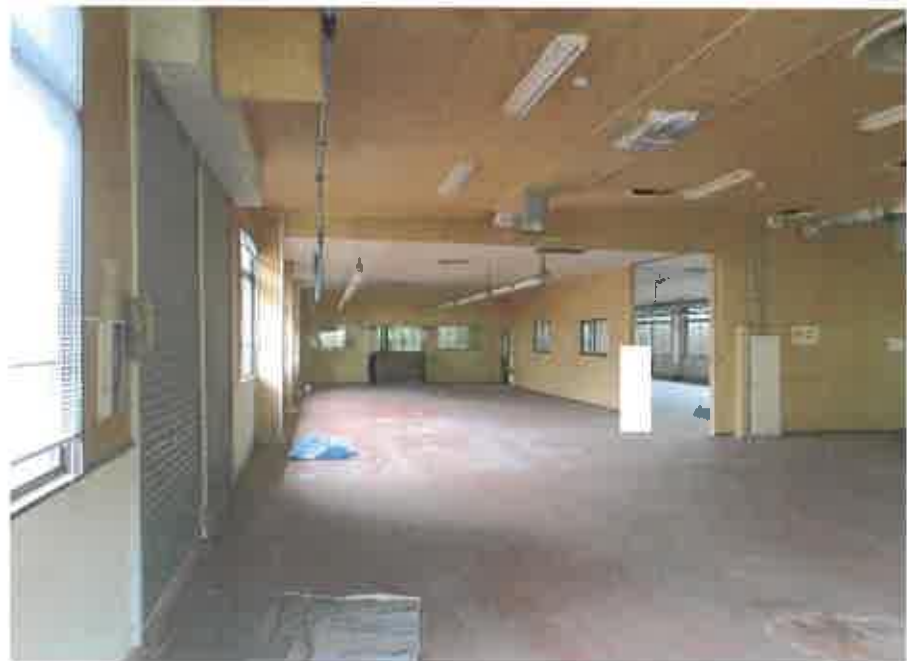
物件10:作業室の状況
