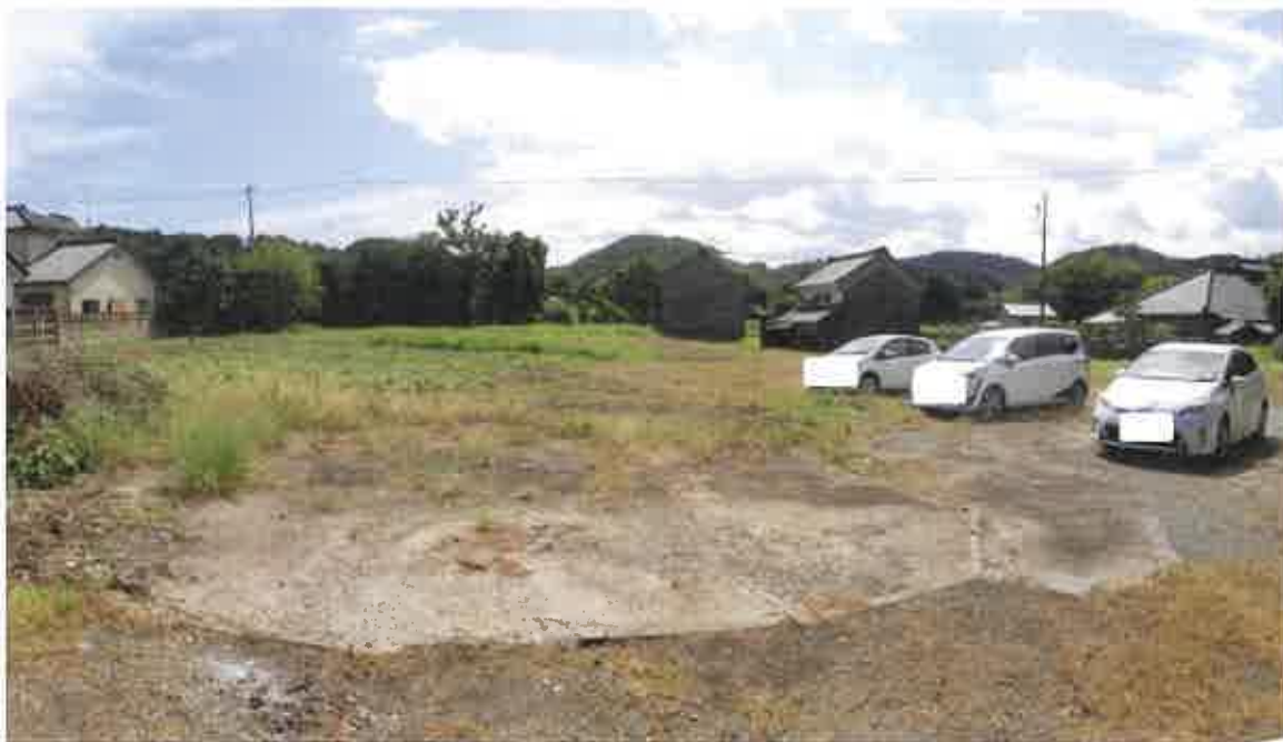
物件 1 0 未登記附属建物の状況
