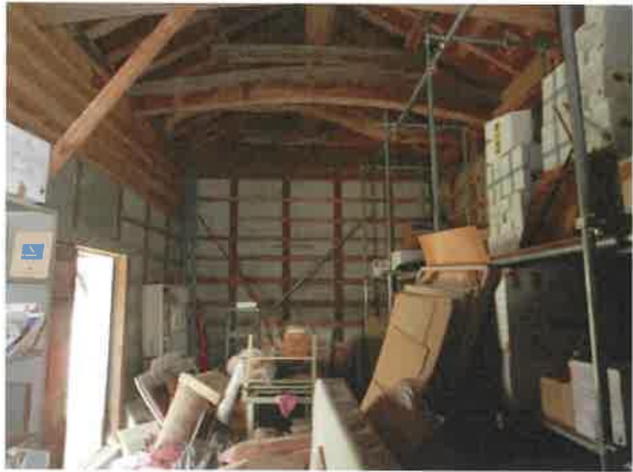
物件 1 0 未登記附属建物 2 の内部の状況
