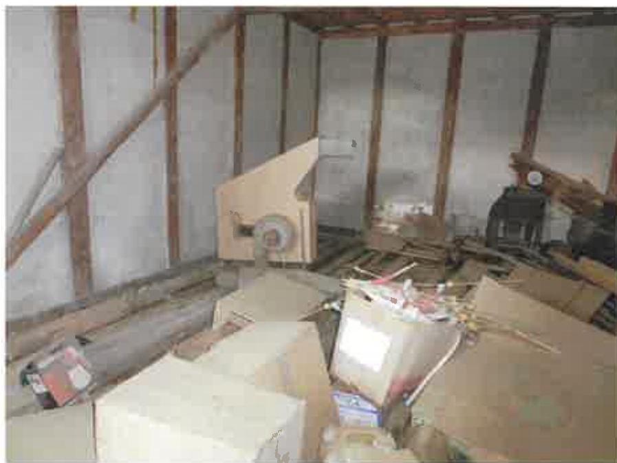
物件 1 0 未登記附属建物 1 の内部の状況
