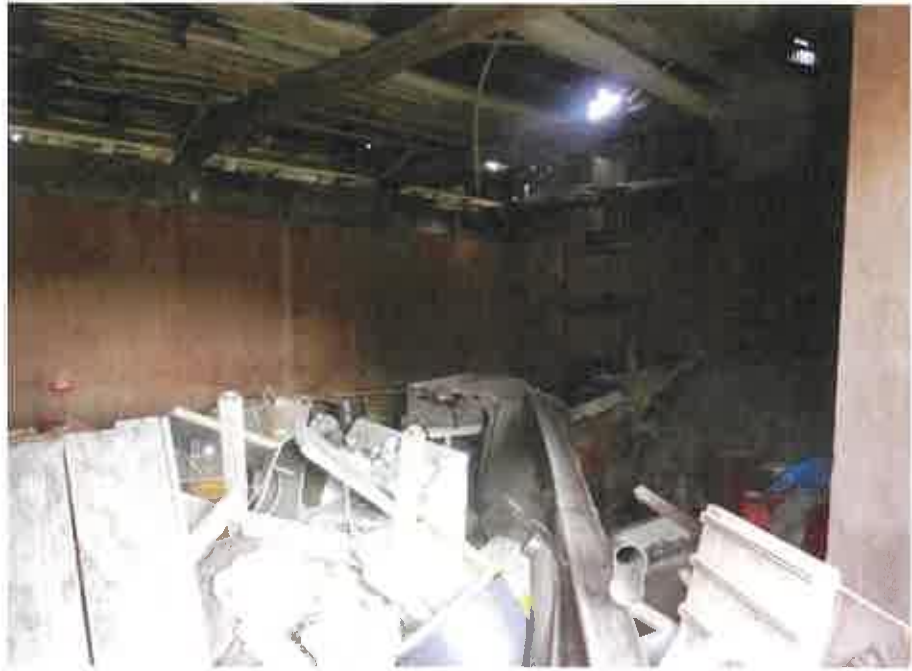
物件 1 2 附属建物符号 2 の内部の状況
