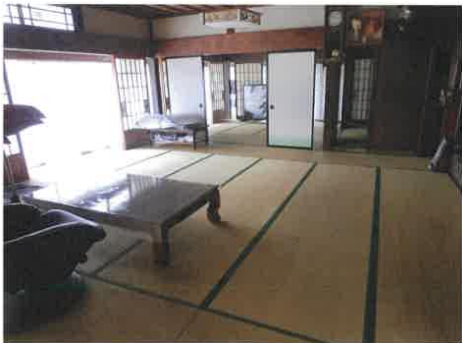
物件 1 2 建物の内部の状況
