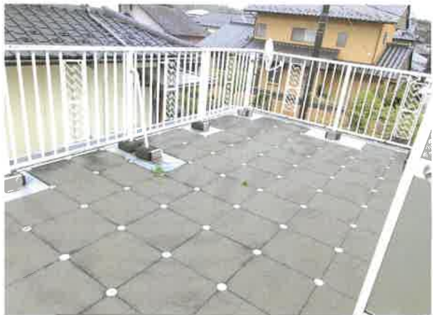
物件2:2階東側ベランダの状況
