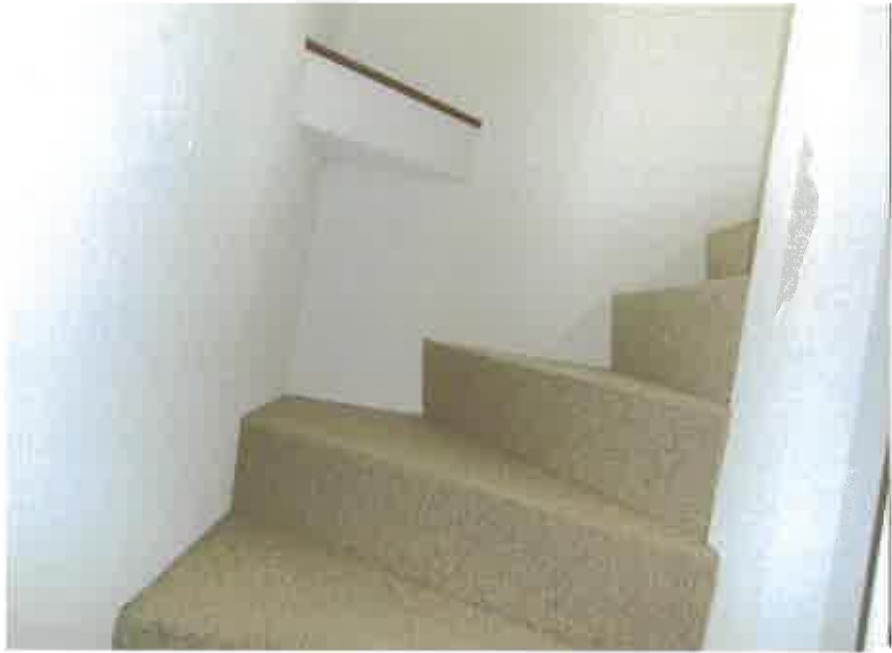
物件2:階段の状況
