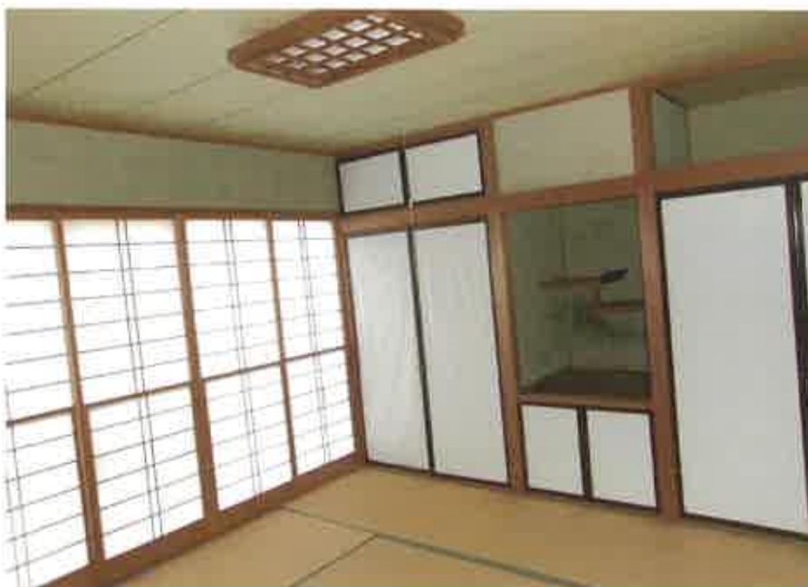
物件2:1階和室の状況
