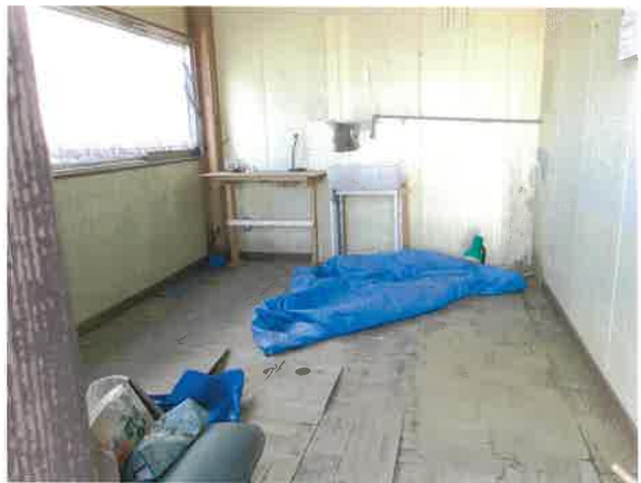
物件2附属建物符号1:2階事務所の状況
