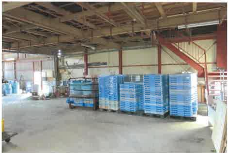
物件2主である建物：1階倉庫南西側の状況
