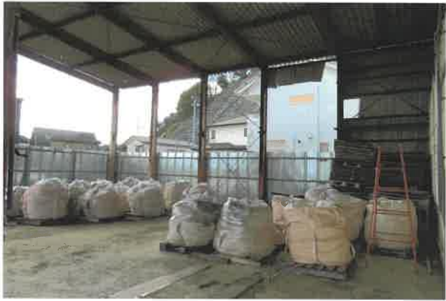
物件2主である建物:1階作業場の状況
