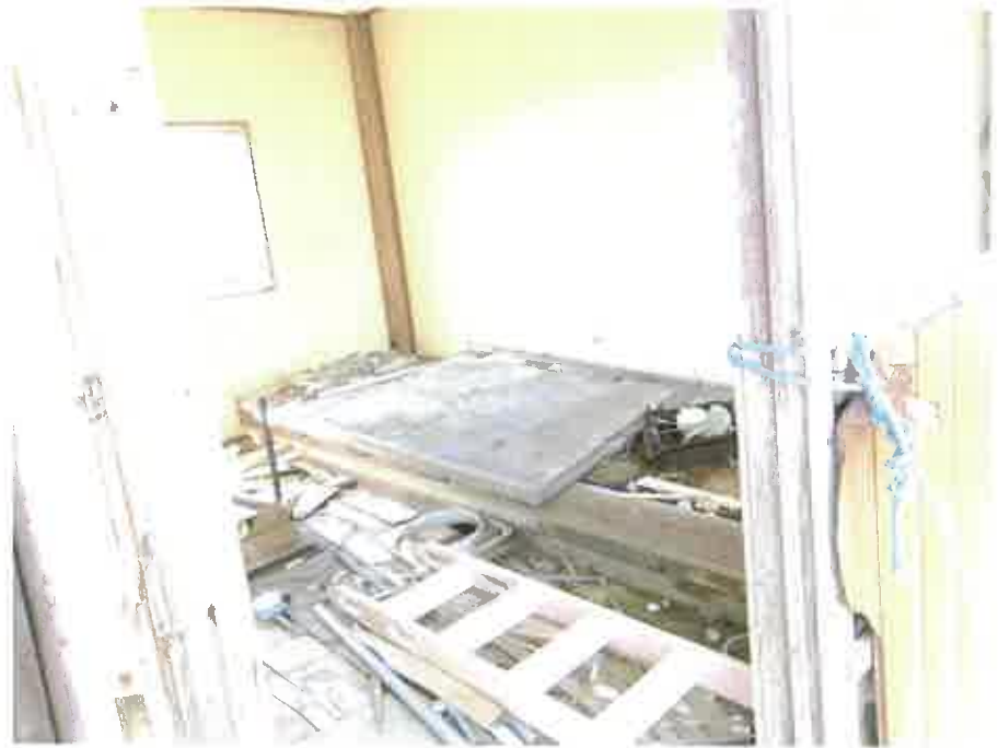
物件2附属建物符号1:2階休憩室の状況
