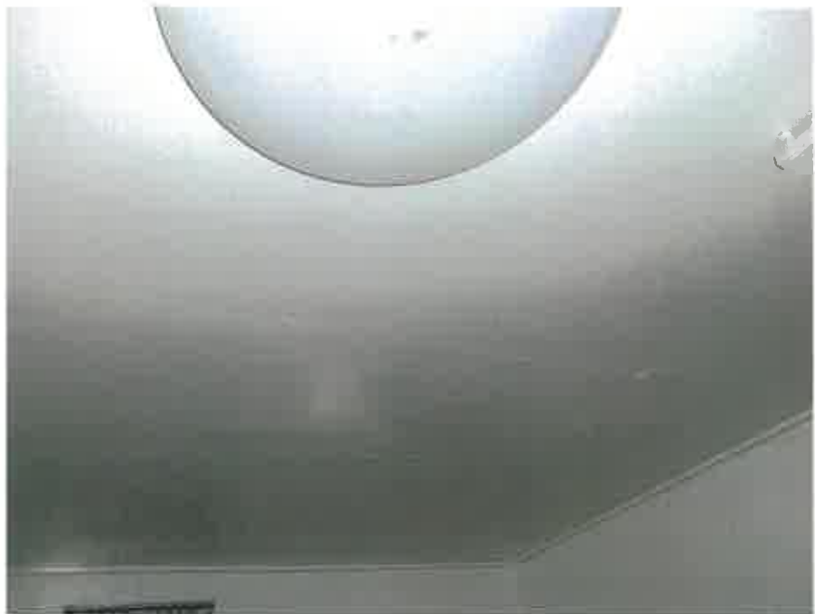
物件2主である建物:2階寄宿舍部屋②天井部分
