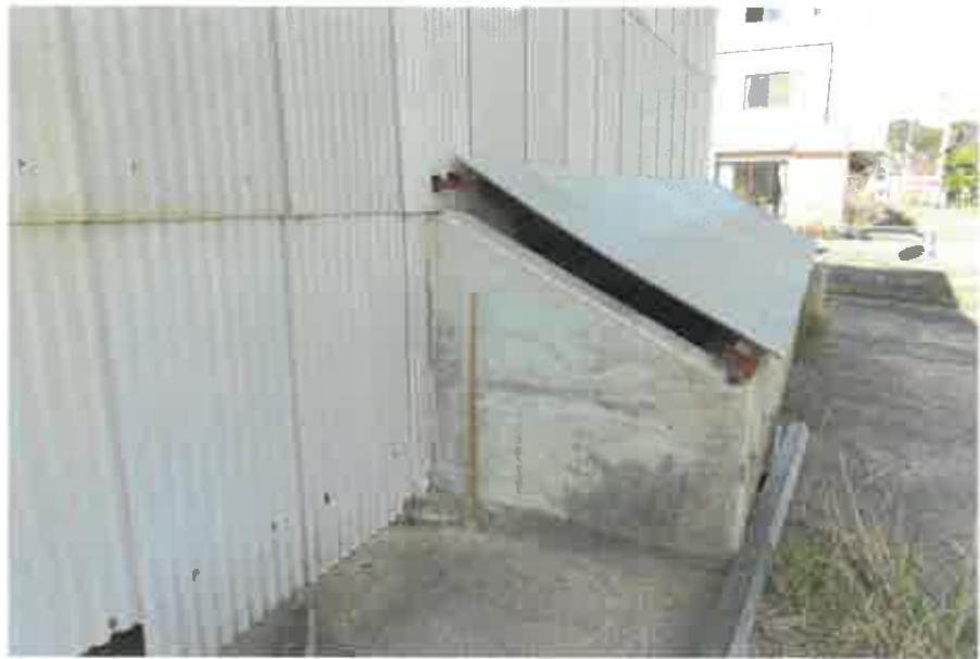
物件2主である建物:1階倉庫水槽部分
