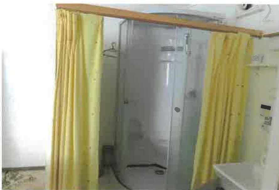
物件2主である建物:2階寄宿舍シャワー室の状況
