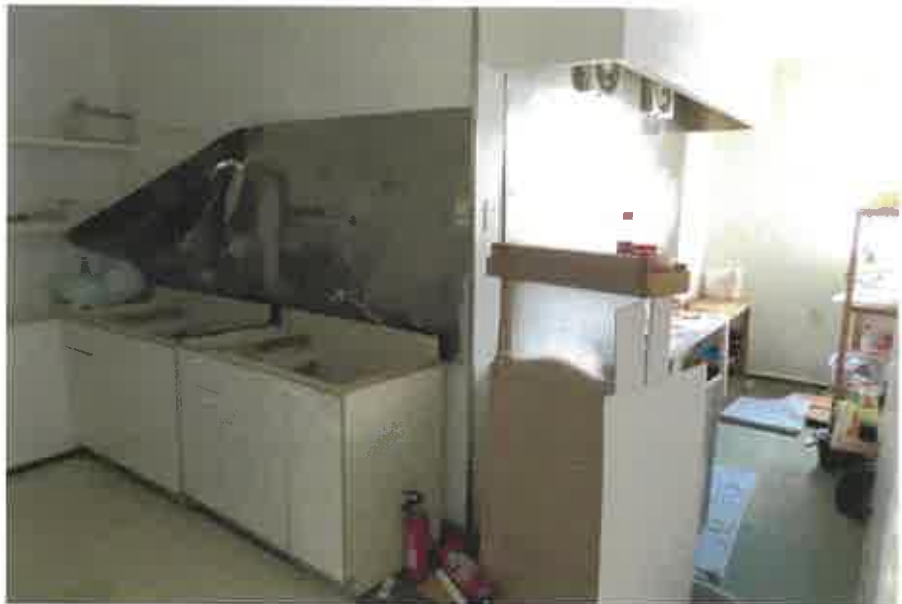
物件2主である建物:2階寄宿舍台所の状況
