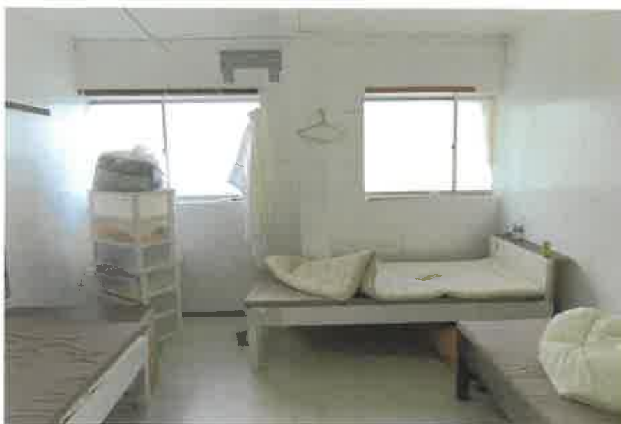
物件2主である建物:2階寄宿舍部屋④の状況
