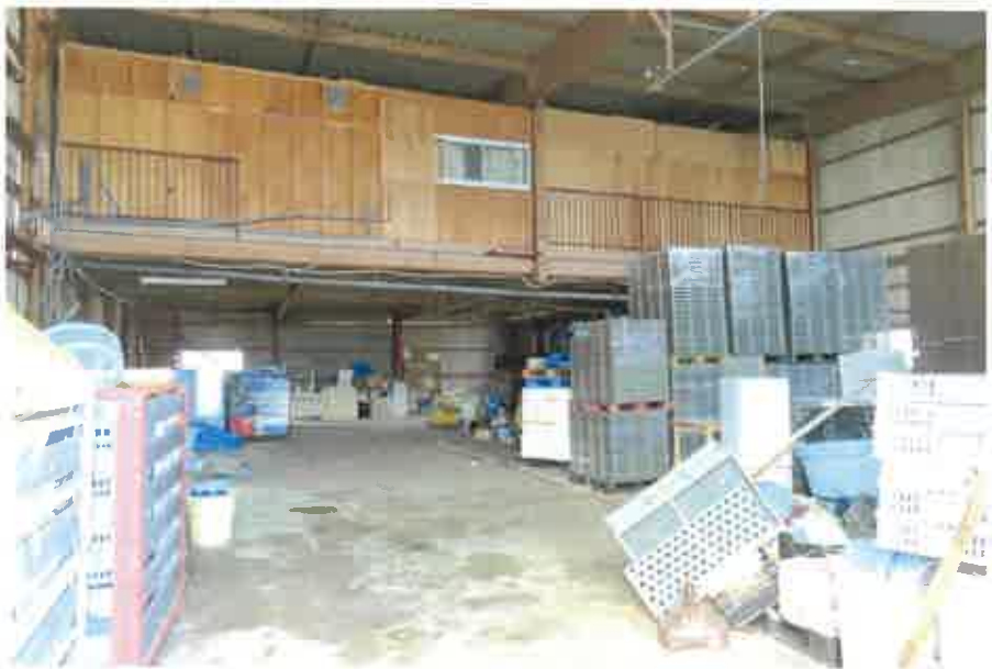
物件2主である建物:1階倉庫北西側の状況
