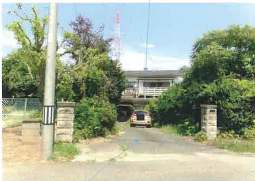
物件4主である建物、物件5
