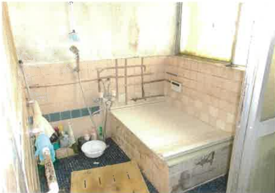
物件4主である建物:浴室の状況
