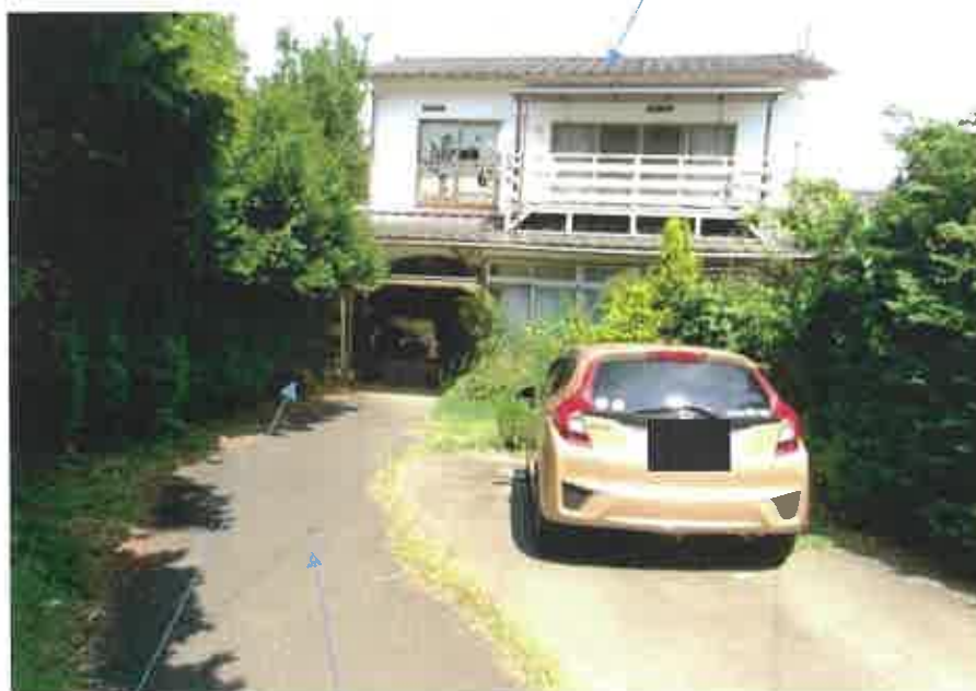
物件4主である建物、物件5
