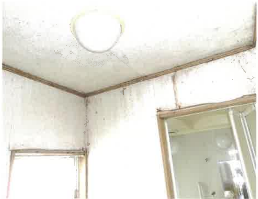
物件1:1階洗面所天井部分の状況
