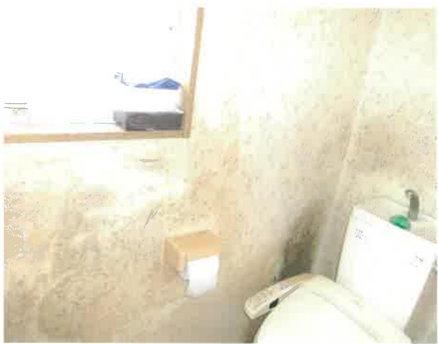
物件1:1階トイレ壁面の状況
