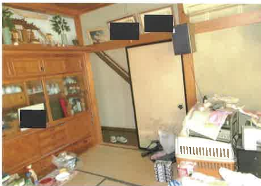
物件1:1階東側和室 の状況
