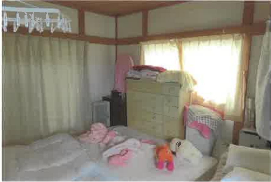
物件2:2階和室の状況
