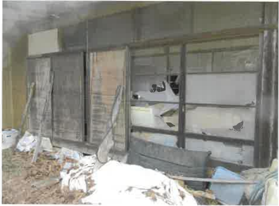
物件3:廊下部分の建具の状況
