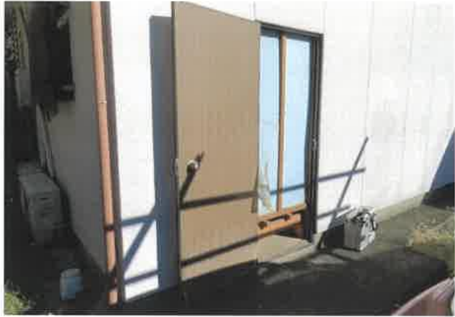
物件1:西側外壁に設置されているドアを開いた状況
