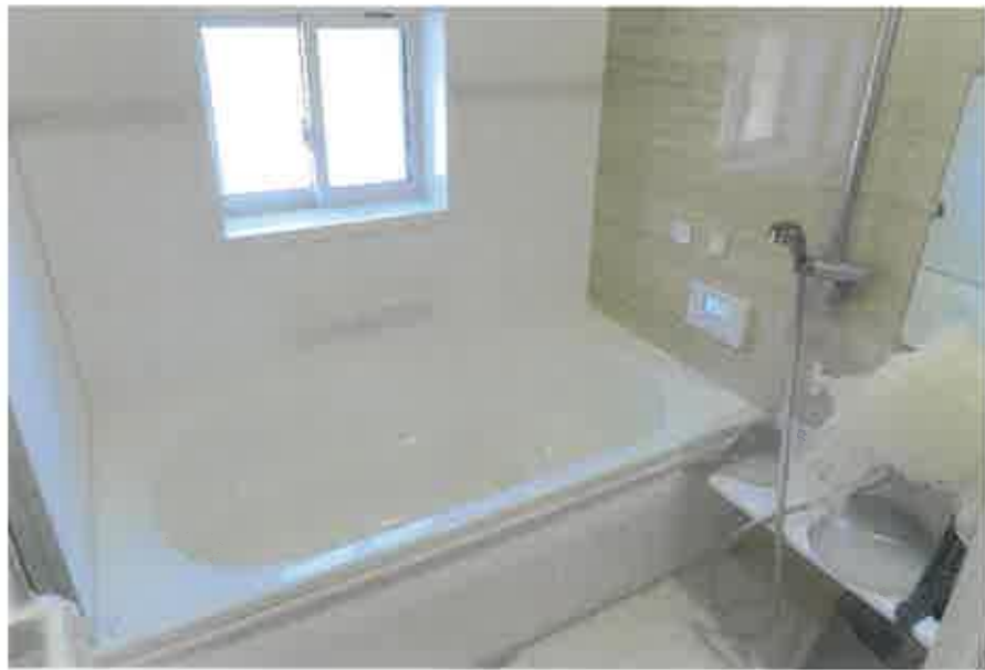
物件2:1階浴室の状況
