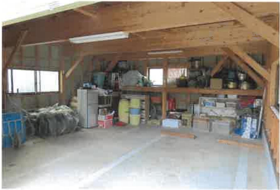
物件2未登記附属建物:内部の状況
