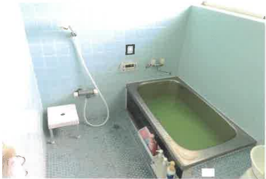
物件2主である建物: 1階浴室の状況
