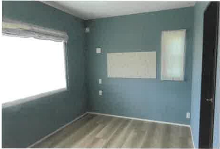
物件3:2階南西側洋室の状況
