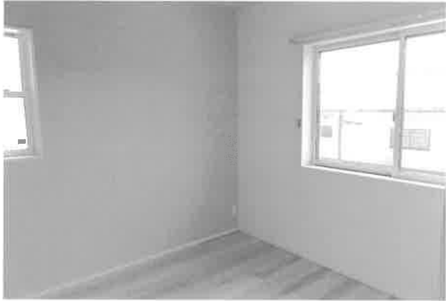
物件3:2階南東側洋室の状況
