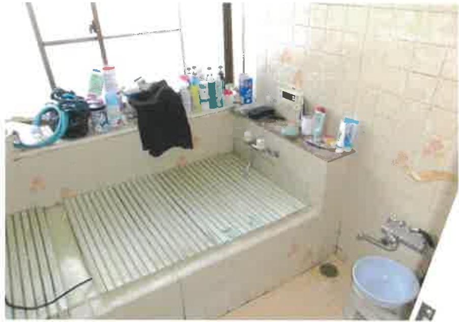
物件2:1階浴室の状況
