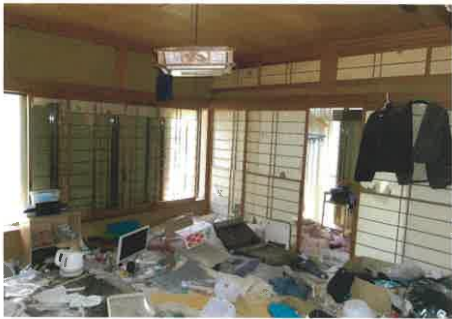
物件2:1階南側和室の状況
