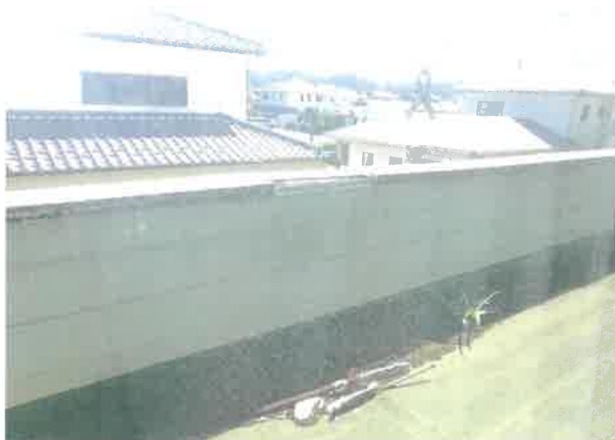
物件1:2階ベランダの状況
