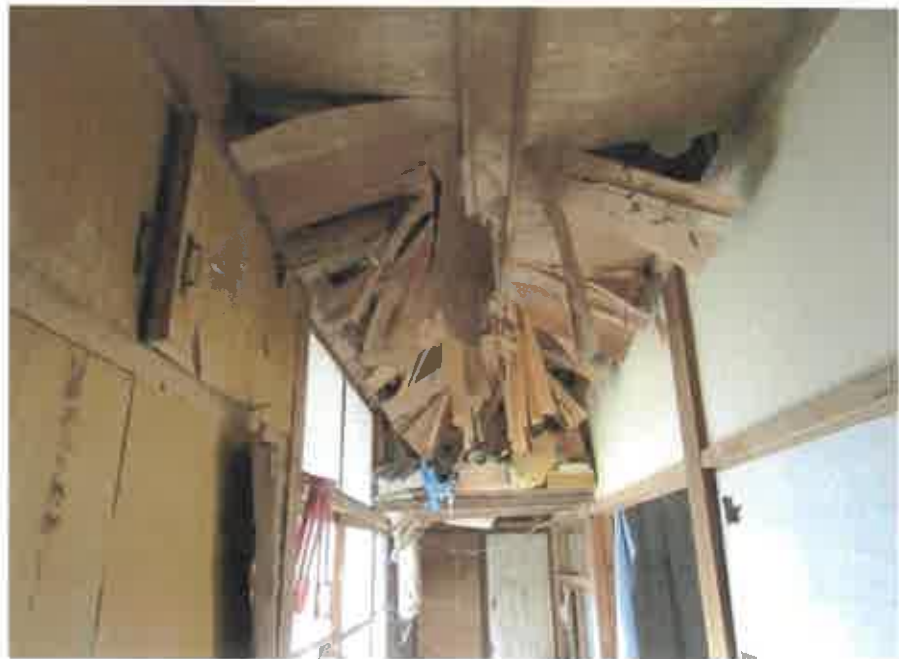
物件3: 廊下の天井の状況
