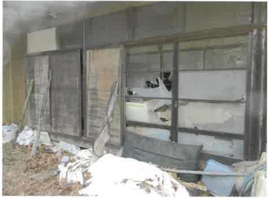
物件3:廊下部分の建具の状況
