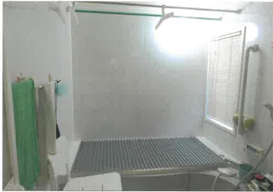
物件2:主である建物1階浴室の状況
