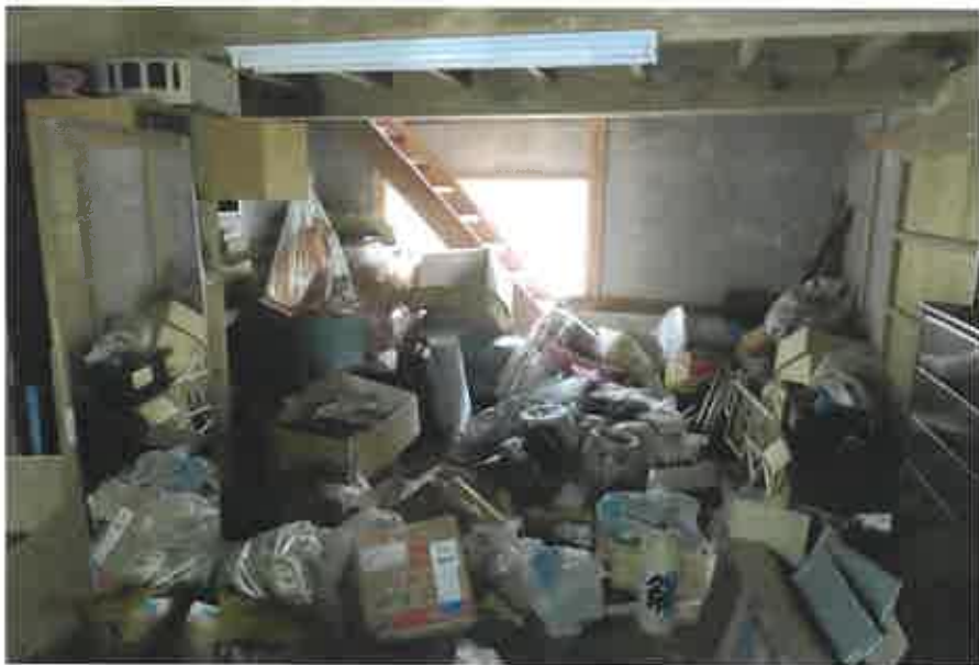
物件2附属建物符号1:1階中央物置の状況
