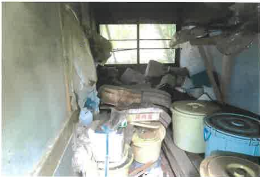
物件2附属建物符号1:1階北側物置の状況
