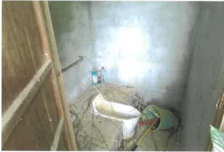
未登記附属建物1:便所の状況
