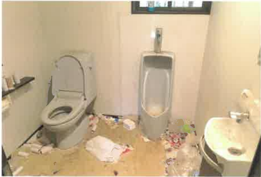
物件2主である建物: 1階トイレの状況
