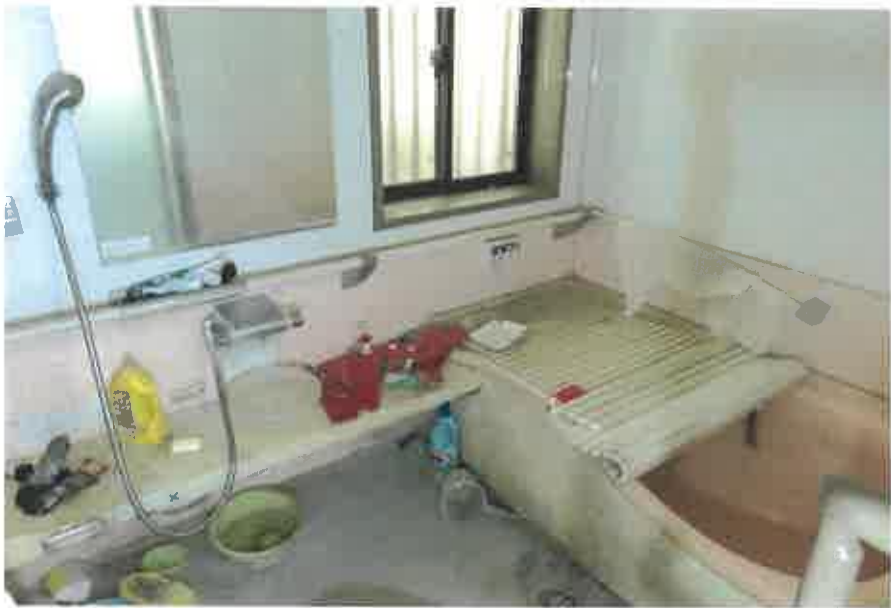
物件2主である建物: 1階浴室の状況
