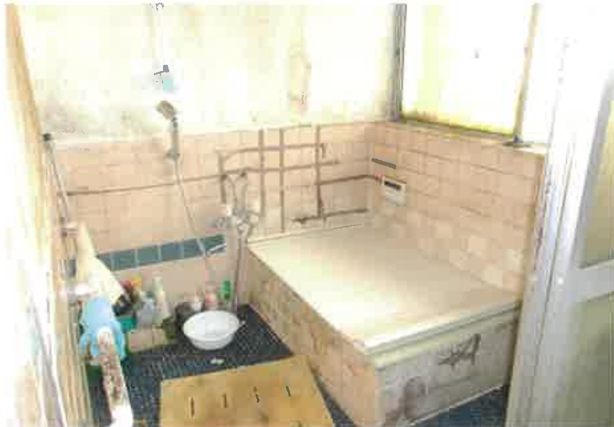
物件4主である建物:浴室の状況
