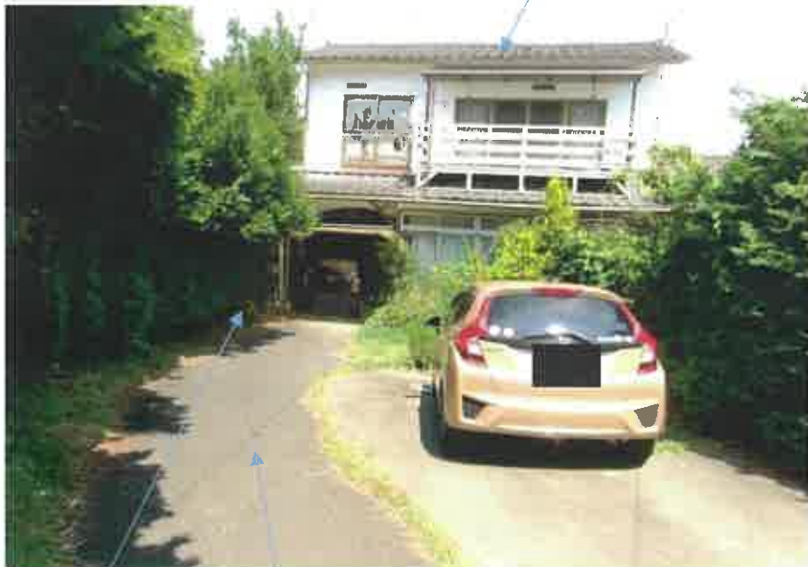
物件4主である建物、物件5
