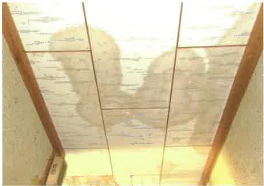
物件4主である建物:建物中央和室の北側廊下天井部分の状況
