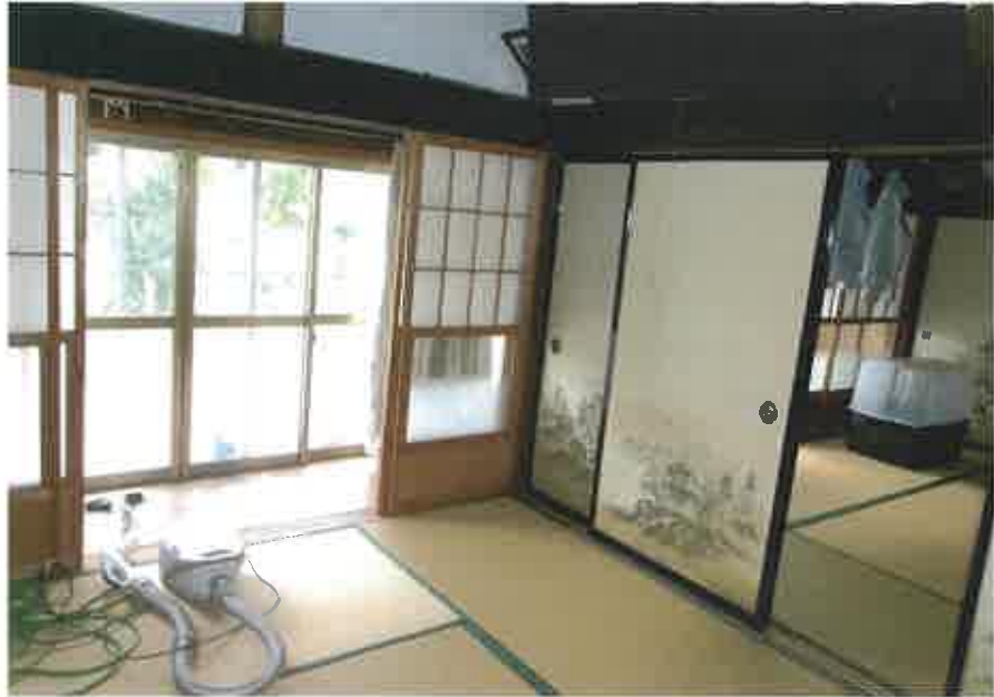
物件4主である建物:南西側(玄関の西側)和室の状況
