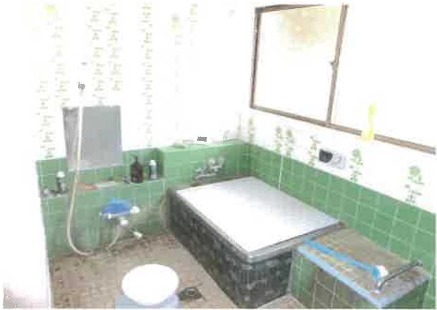
物件4主である建物:浴室の状況
