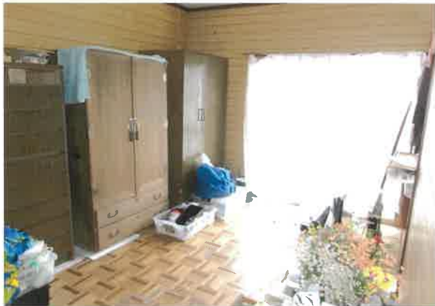
物件4主である建物:洋室の状況
