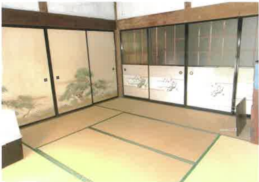
物件4主である建物:南西側(建物西端)和室の状況
