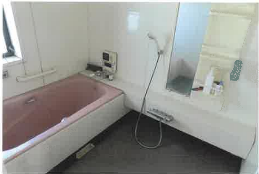
物件2:1階浴室の状況
