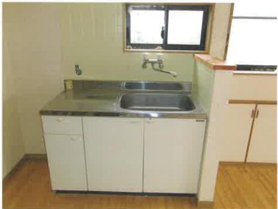
物件2:2階東側洋室キッチンの状況
