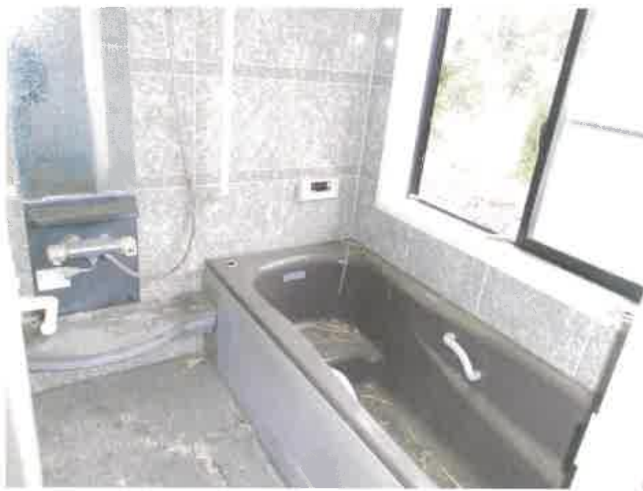
物件2:1階浴室の状況
