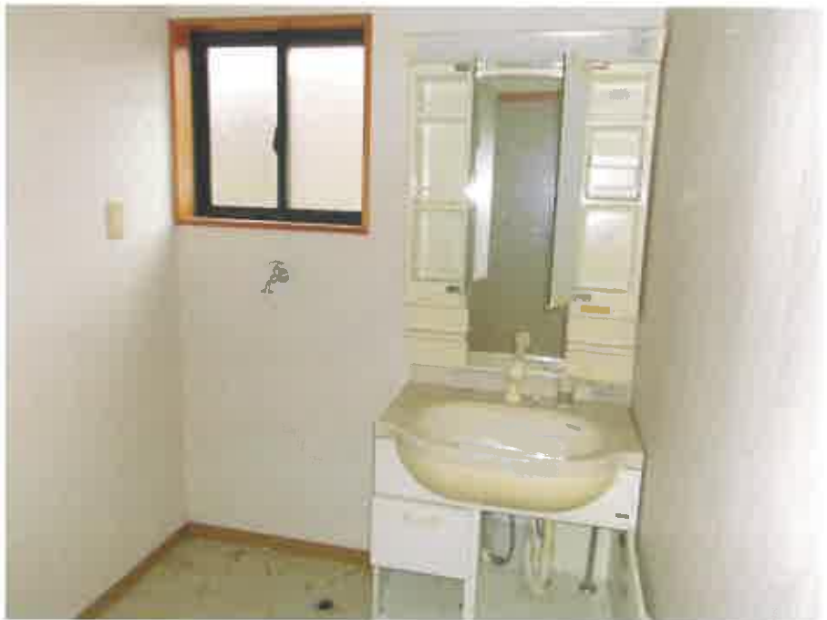
物件2:1階洗面所の状況
