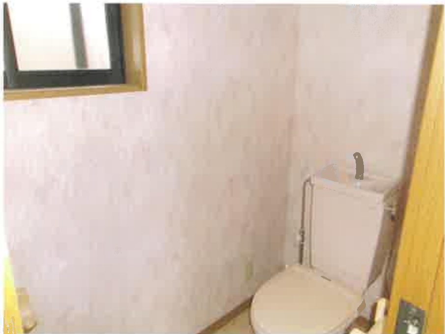
物件2:2階トイレの状況
