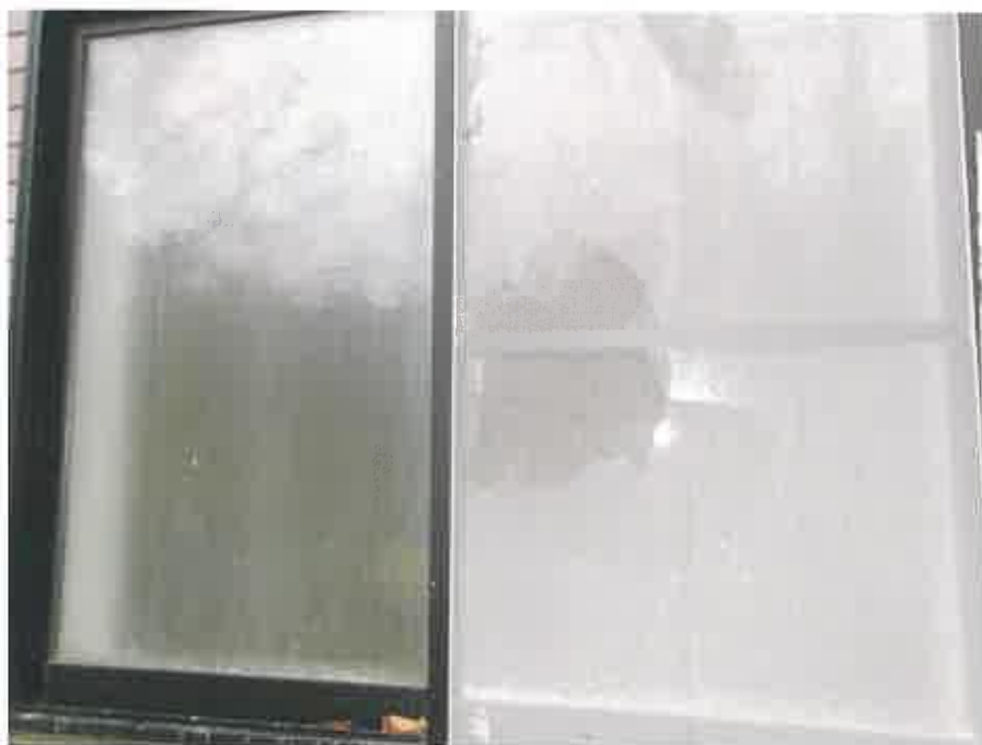
物件2:1階浴室外部
