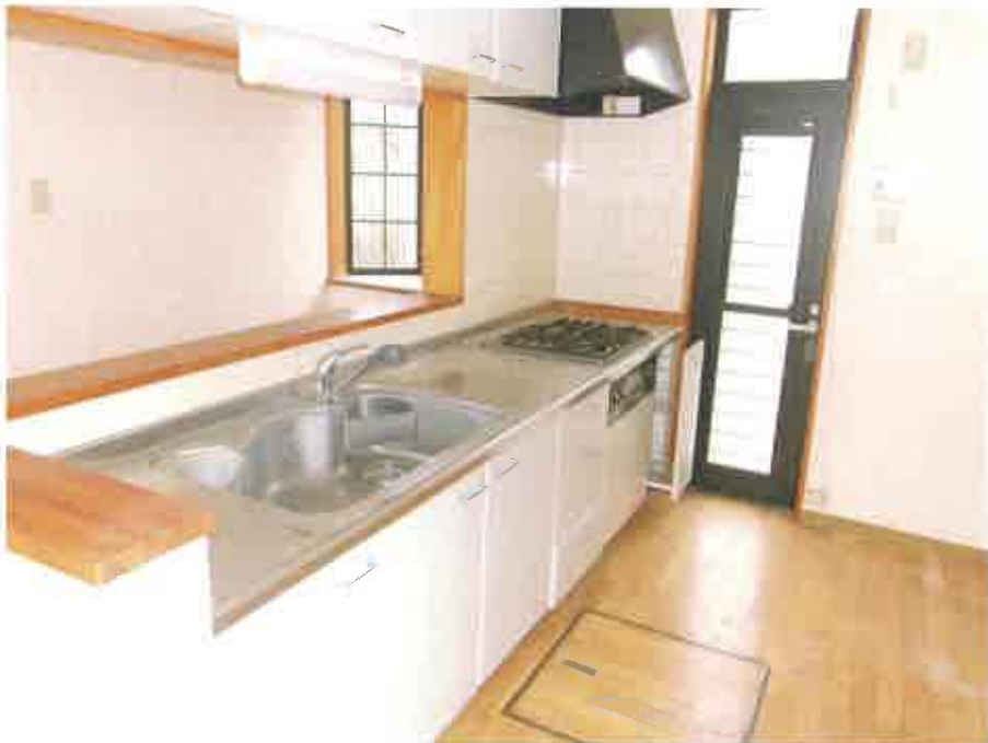
物件2: 1階キッチンの状況
