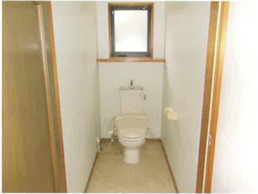
物件2:1階トイレの状況
