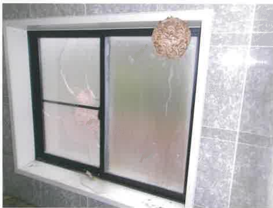
物件2:1階浴室窓部分の状況
