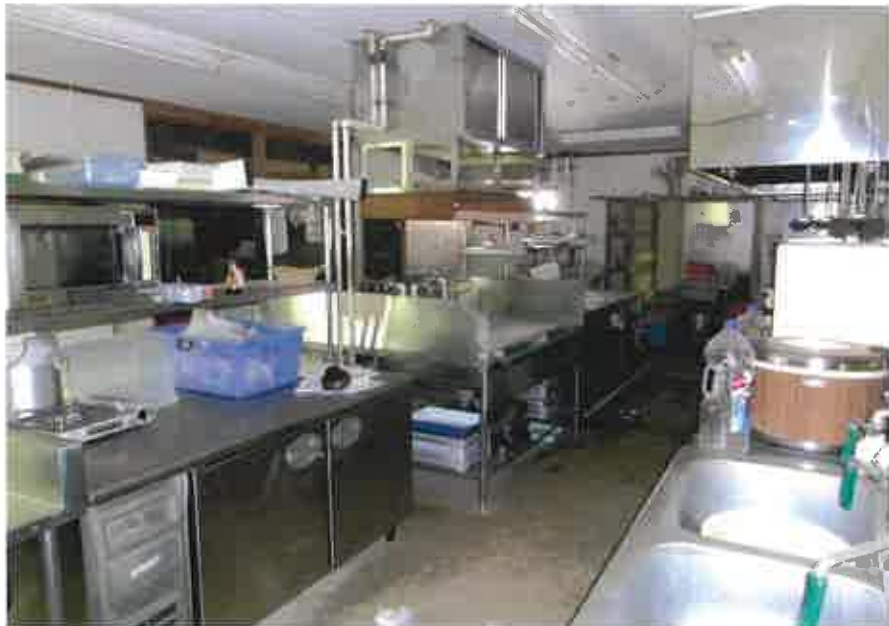
物件7主である建物:ホテル本館厨房の状況
