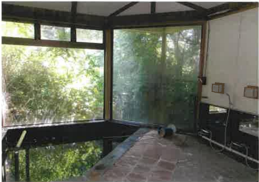
物件7主である建物:ホテル浴室棟 南側浴室の状況
