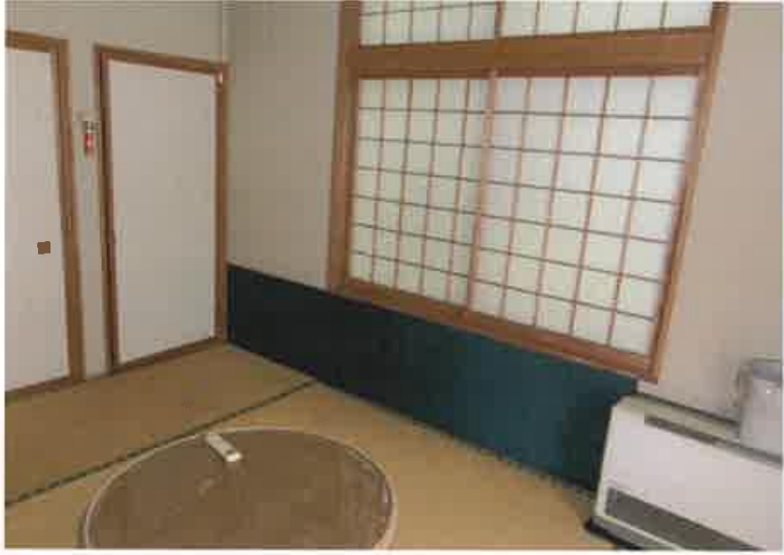
物件7主である建物:湯治棟1 1階和室313の状況
