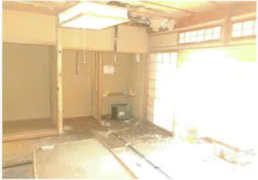
物件7主である建物:特別室北側和室の状況
