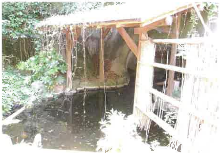
物件7主である建物:湯治棟2 脱衣室男から洞窟風呂を撮影
