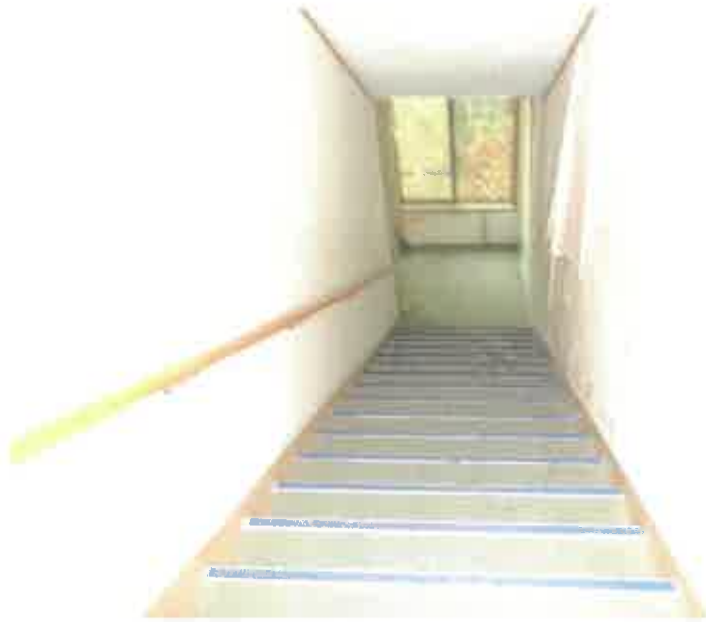
物件7主である建物:ホテル浴室棟から湯治棟2への通路の状況
