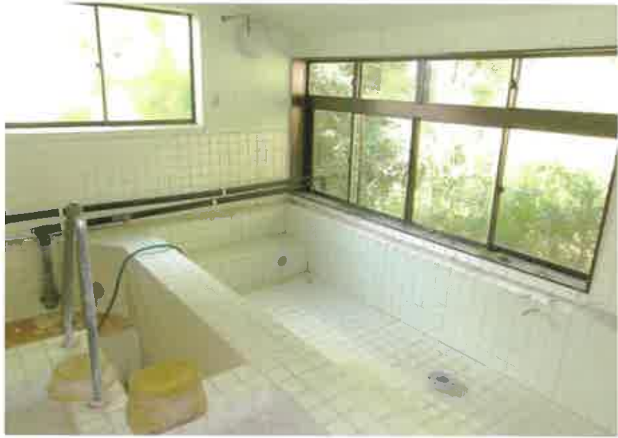
物件7主である建物:湯治棟1 1階南側浴室の状況
