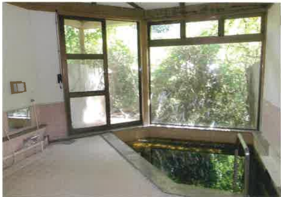
物件7主である建物:ホテル浴室棟 北側浴室の状況
