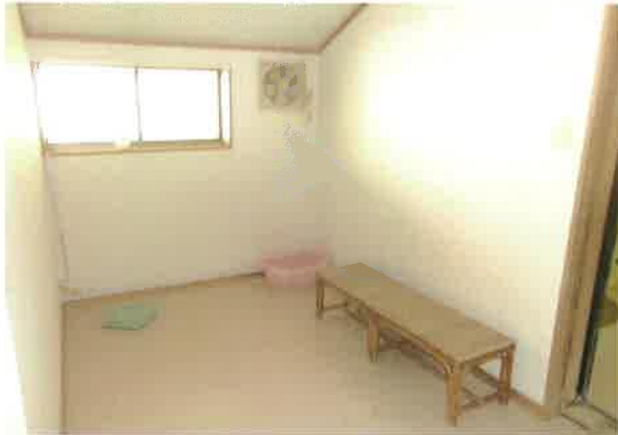
物件7主である建物:湯治棟1 北側脱衣室の状況
