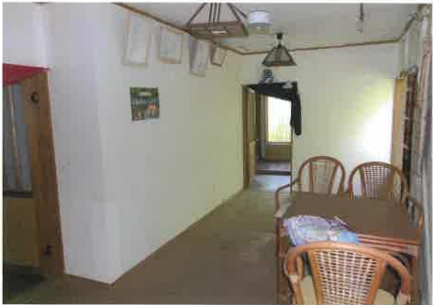
物件7主である建物:ホテル浴室棟 ロビーの状況
