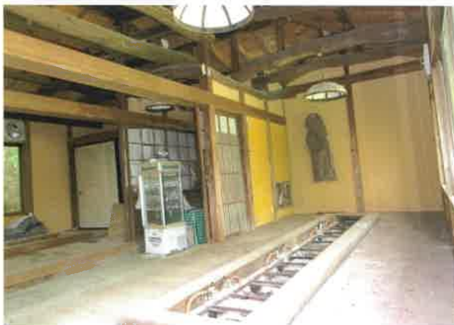
物件7附属建物符号2:東側座敷の状況
