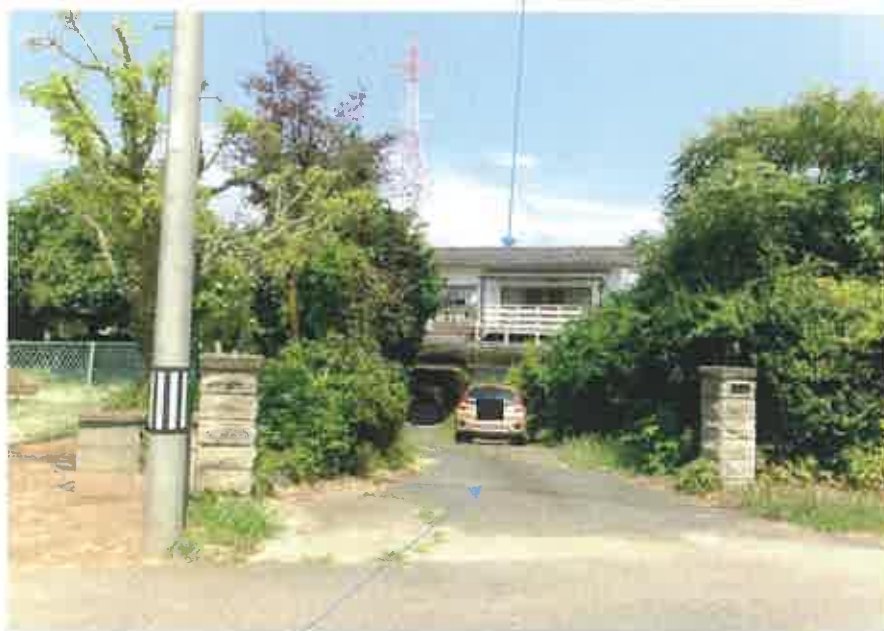
物件4主である建物、物件5
