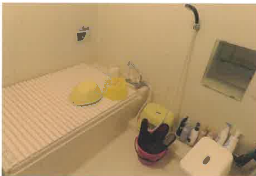
物件2:浴室の状況
