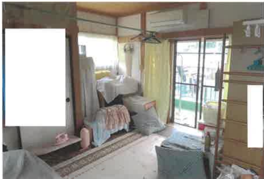
物件2:2階洋室の状況
