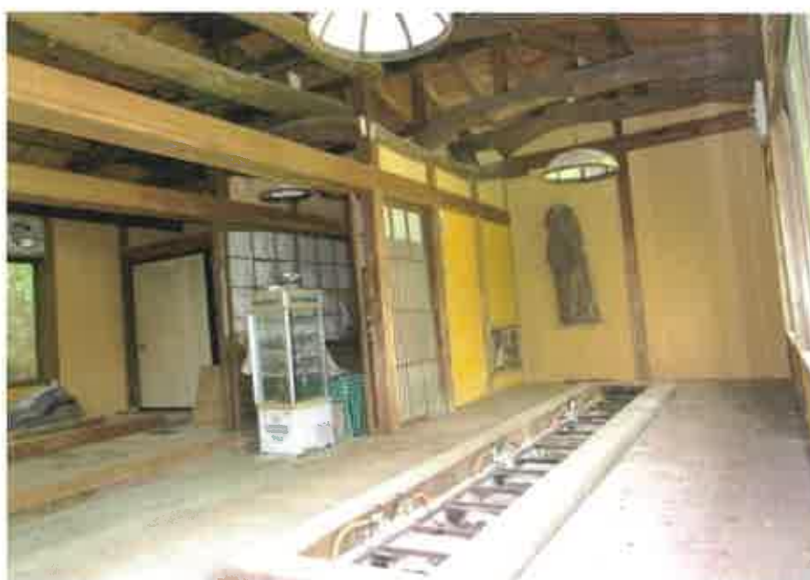
物件7附属建物符号2:東側座敷の状況
