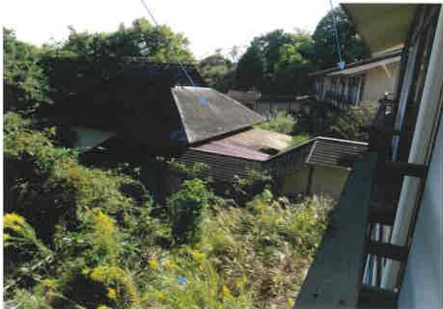
物件7主である建物:ホテル棟 物件7主である建物:ホテル浴室棟
