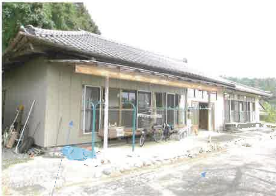
物件4主である建物
