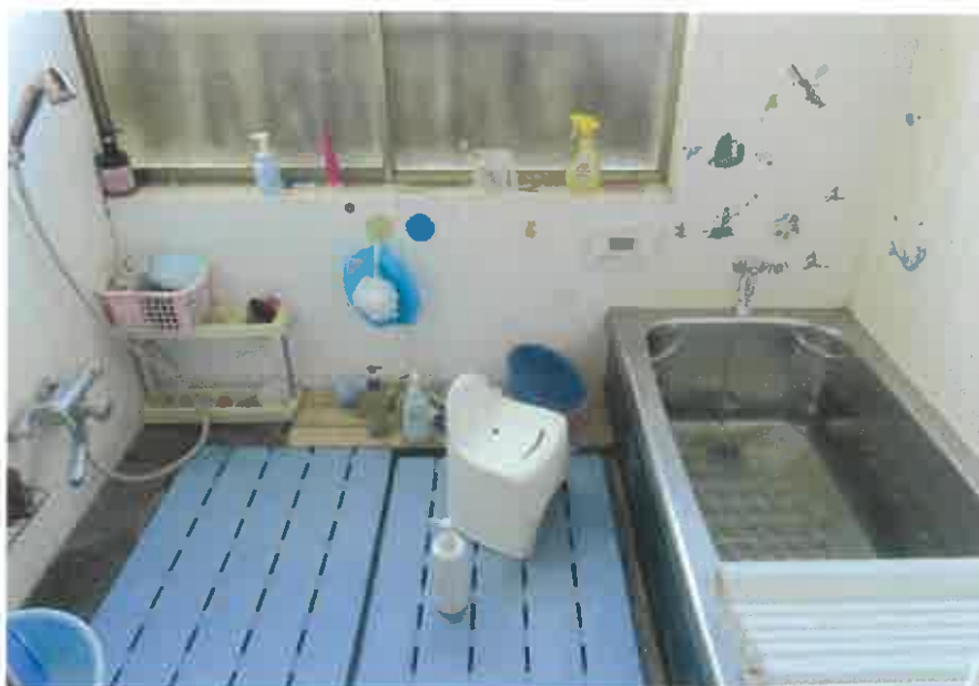
物件2主である建物: 1階浴室の状況
