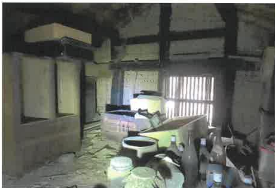
物件3:2階の状況
