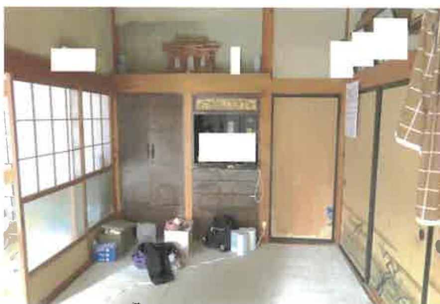
物件2主である建物:和室3の状況
