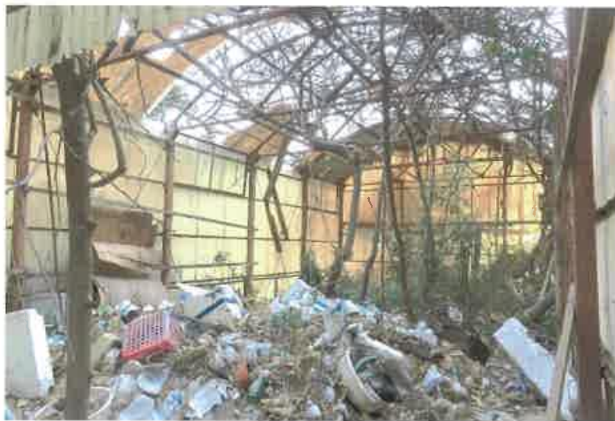
物件2未登記附属建物:内部の状況
