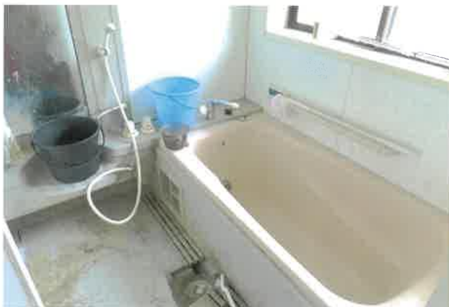
物件2主である建物:浴室の状況
