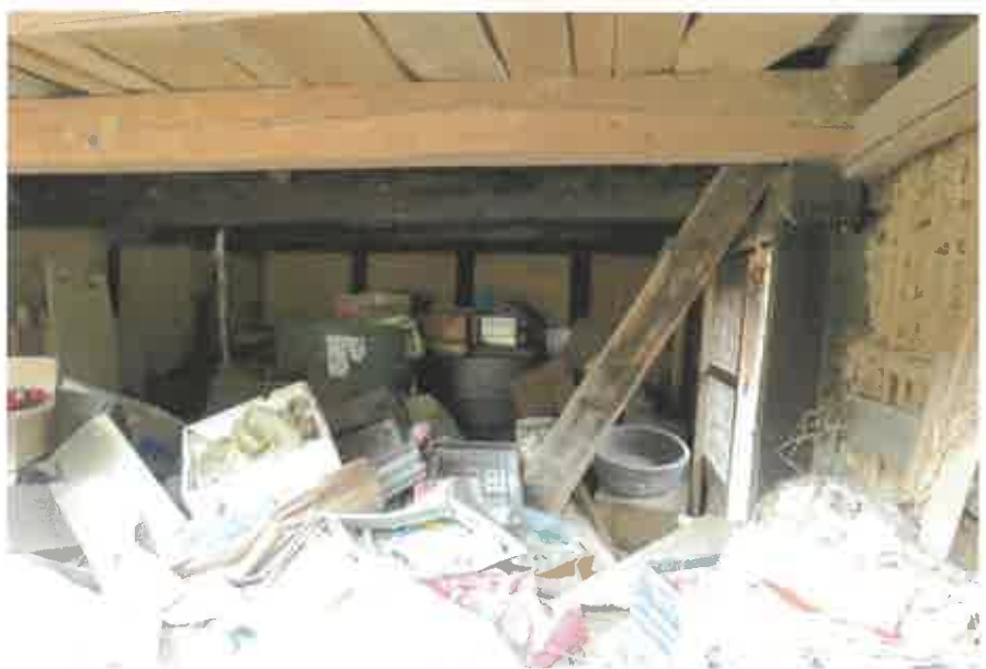
物件3:1階の状況
