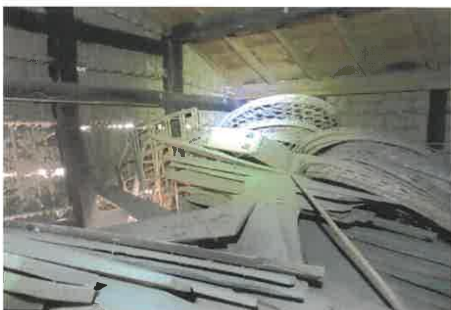
物件3:2階の状況
