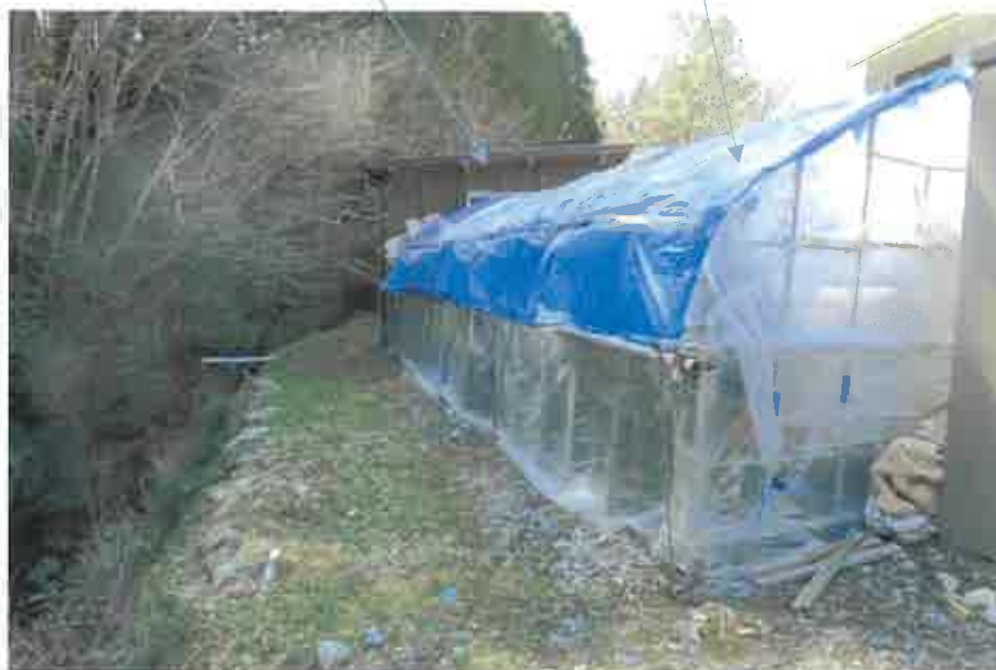
物件4未登記附属建物 ビニールハウス(動産)
