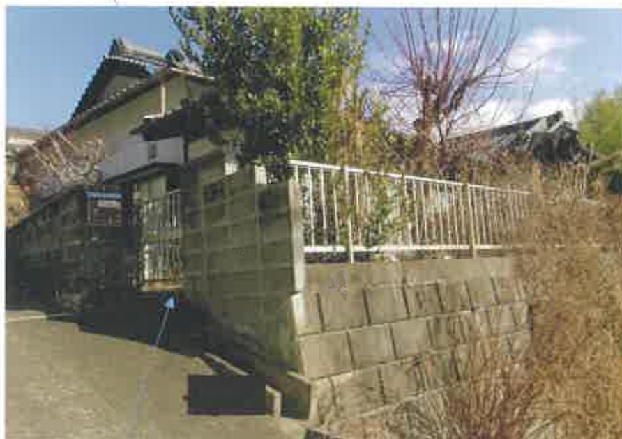
物件2主である建物
