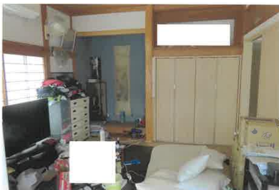
物件2:1階南西側洋室の状況
