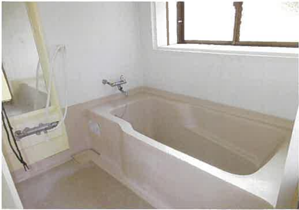
物件6:1階浴室の状況
