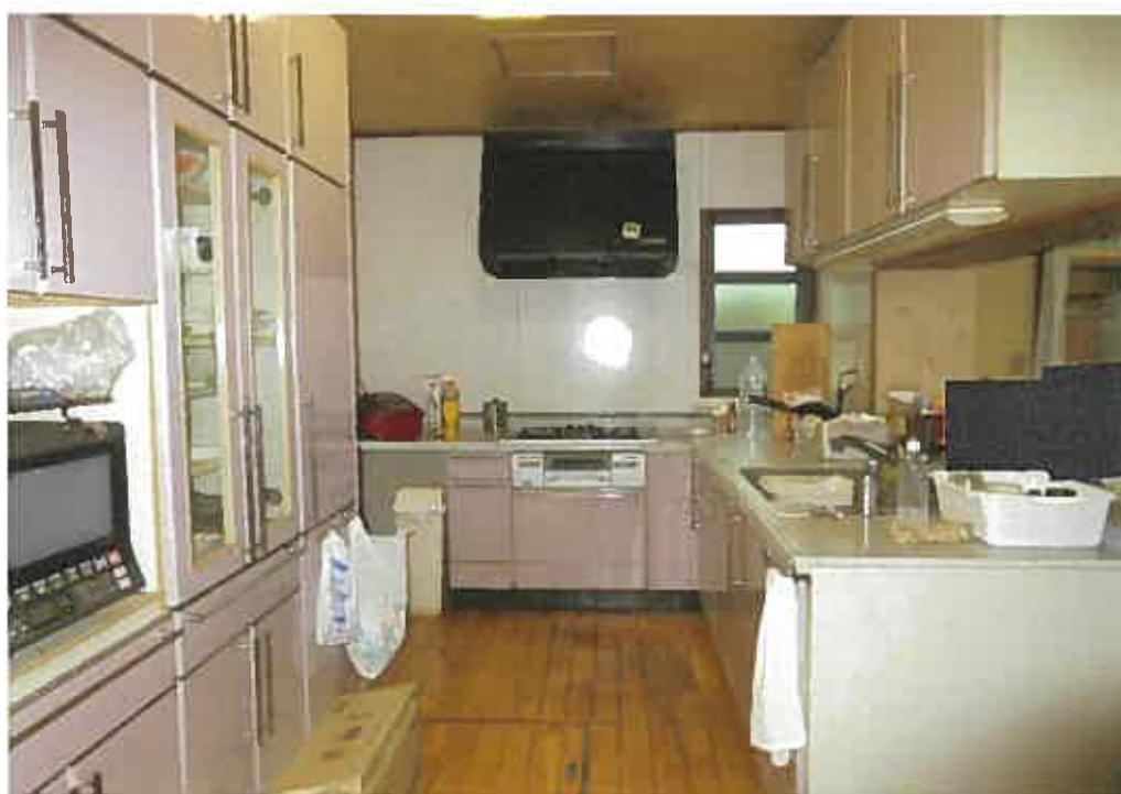
物件3:1階台所の状況
