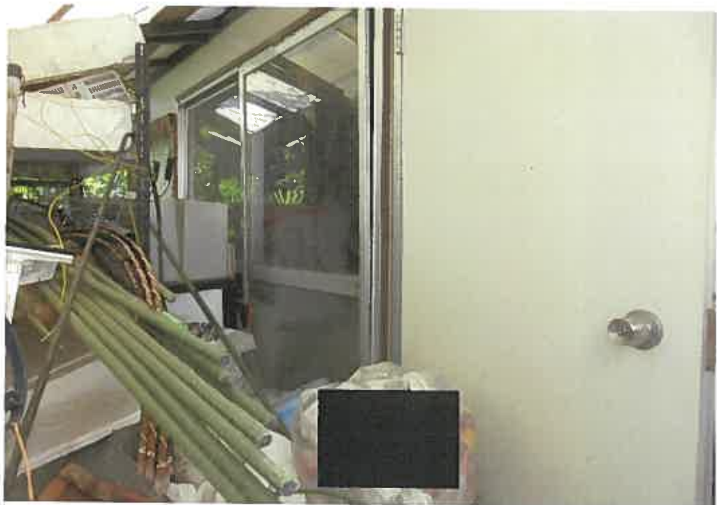
物件2未登記附属建物:下屋部分の状況
