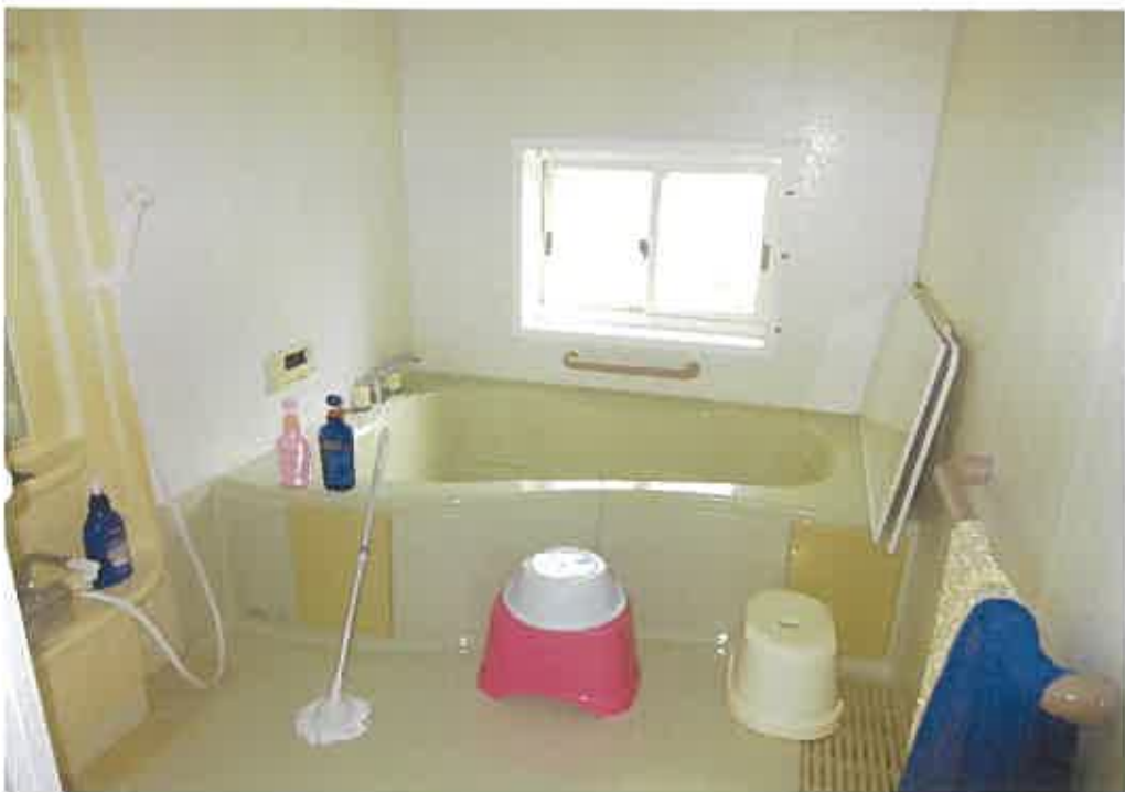
物件4:浴室の状況
